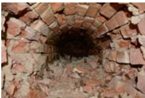
Aktualna struktura murów katakumb: a) widok kilku nisz grzebalnych b) układ cegieł w sklepieniu we wnętrzu niszy
