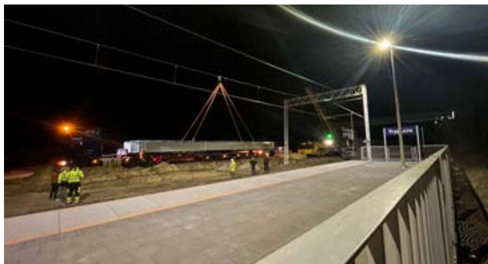
Prace w Trypuciach. Tu droga nad torami będzie budowana w zupełnie nowym śladzie
