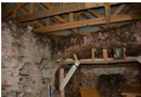
Tymczasowa konstrukcja przekrywająca katakumby: a) widok dachu (zielony) na tle Klasztoru; b) pas dolny kratownicy gwoździowanej
