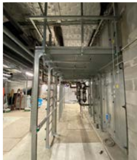
► Konstrukcja podestu – widok z boku
