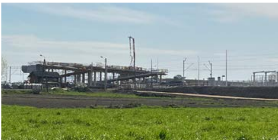
Dąbrowa Łazy. Mała miejscowość, a tak imponująca budowa
