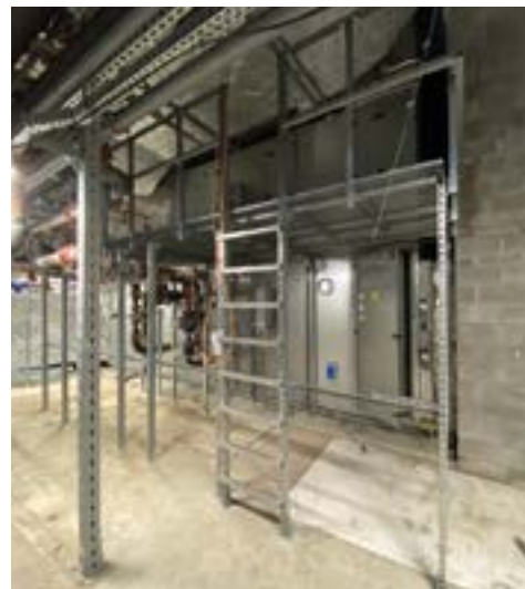
► Konstrukcja podestu – widok od przodu
