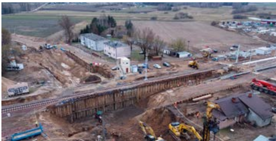
W Baciutach przystanek osobowy zostanie zamieniony na stację i będą tędy przebiegały cztery tory. Droga wojewódzka łącząca Białystok z Wysokiem Mazowieckiem, która przecina tę miejscowość, pobiegnie tunelem pod torami
