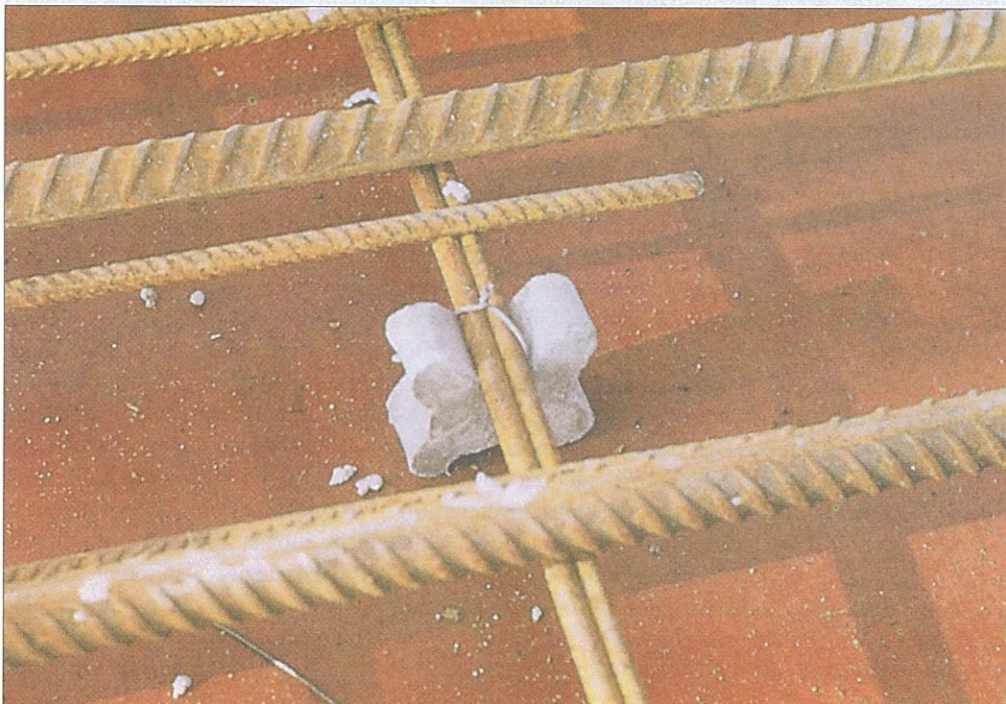
Przykład zastosowania betonowych dystansów przy zbrojeniu
