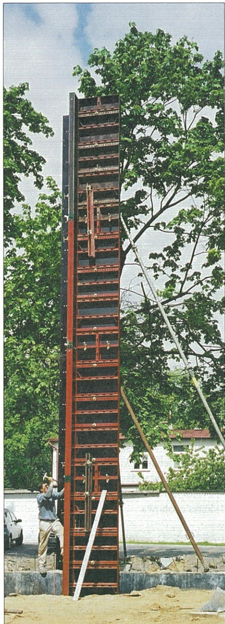
Szalunek uniwersalny słupa LOGO – wysokość 10,80 m – budowa sali wykładowej Wydziału Prawa Uniwersytetu w Białymstoku
