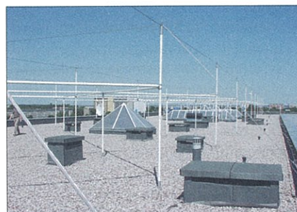
Rys. 6. Ochrona odgromowa urządzeń na dachu obiektu budowlanego
