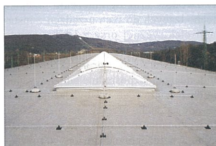
Rys. 5. Przykładowe rozwiązania ochrony nadbudówek na dachu płaskim. [14]
