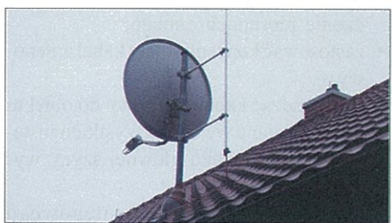
Rys. 9. Ochrona maszty i anteny przed bezpośrednim oddziaływaniem prądu piorunowego [14]
