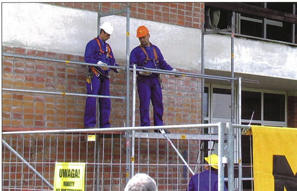
Pokaz prawidłowego montażu rusztowania
