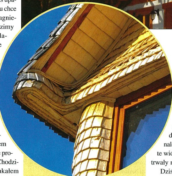
Najtrudniejsze jest rozpoczęcie krycia. Na zdjęciu widać, iż ta warstwa jest szczególnie gruba
