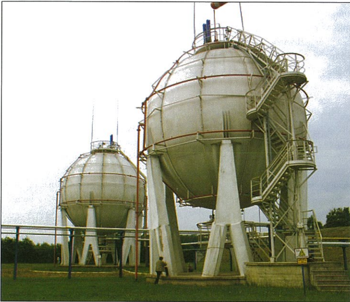
Rys. 1.1. Kuliste powłoki zbiorników gazu propan-butan
