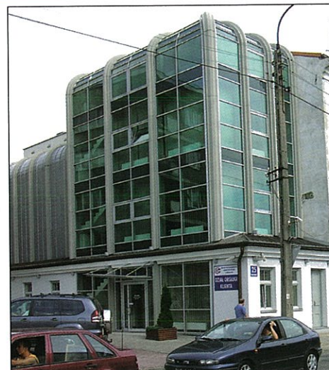
Budynek administracyjny MPEC przy ul. Warszawskiej 25 w Białymstoku
