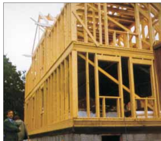
Rys. 2c. Tradycyjny sposób realizacji (system żebrowy)
