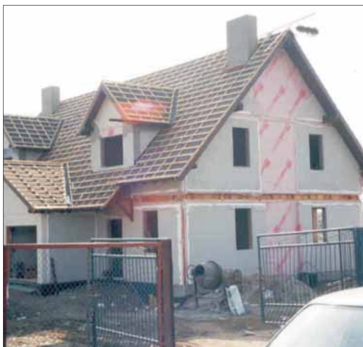
Rys. 2a. Szkieletowy budynek drewniany w trakcie realizacji (system płytowy)
