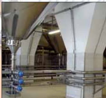
Budynek tankofermentatorów ze stacją odzysku CO 2 i CIP w białostockim Browarze. Jak realizowano tę nietypową budowę – str. 14
