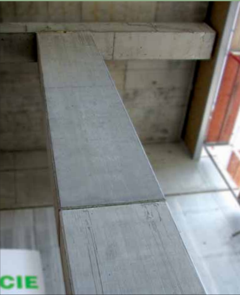
Widok od dołu słupa podtrzymującego cały obiekt
