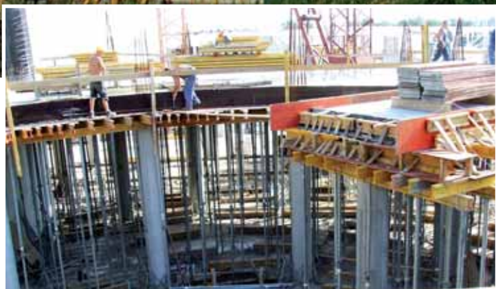
Fragment konstrukcji rotundy wejściowej
