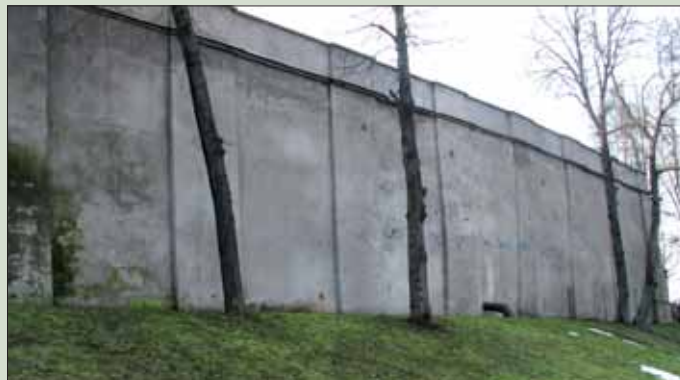
Mur wschodni w rejonie komory odciążającej
