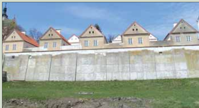
Widok na południowy mur oporowy dolnego tarasu eremowego
