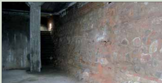
Wnętrze komory odciążającej mur wschodni
