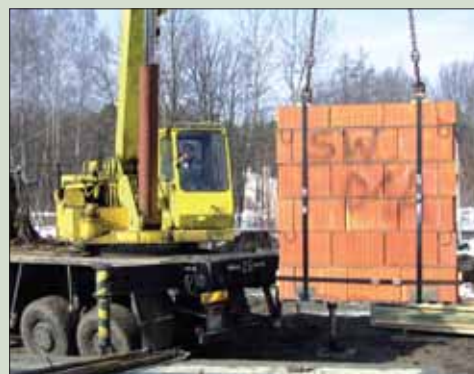
Technologia prefabrykowanych ścian murowanych w systemie CETE firmy Unihouse z Bielska Podlaskiego
