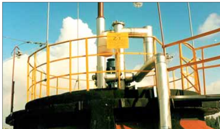
Rys. 9. Odbudowana konstrukcja powłoki stożkowej z systemem instalacji
