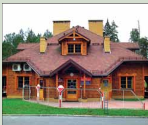
Międzynarodowe Drogowe Przejście Graniczne w Białowieży, wykonawca Unibep Bielska Podlaski
