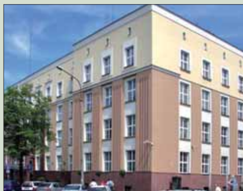
Rozbudowa i modernizacja siedziby Podlaskiego Urzędu Wojewódzkiego w Białymstoku, zrealizowana przez firmę Unibep z Bielska Podlaskiego
