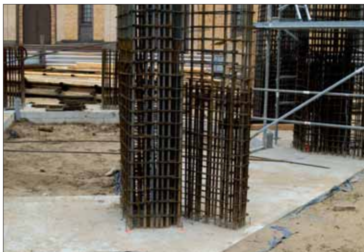
Zbrojenie słupów nośnych wieży (od poziomu 0,00 do poziomu +7,70)
