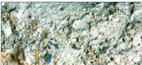
Rys. 6. Powierzchnia skarbonizowanej warstwy otuliny betonowej
