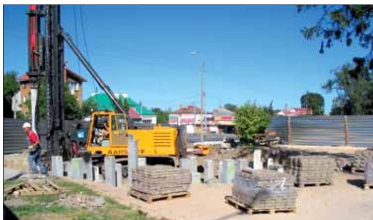
Urządzenie do wbijania pali prefabrykowanych
