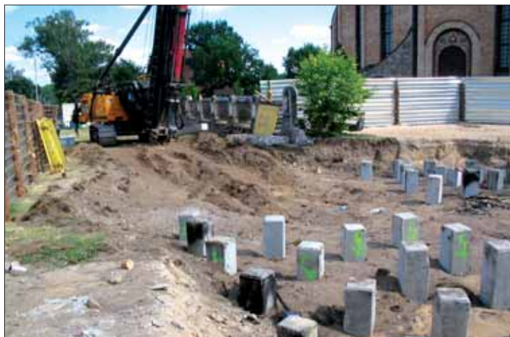
Fragment układu pali pod fundamentem
