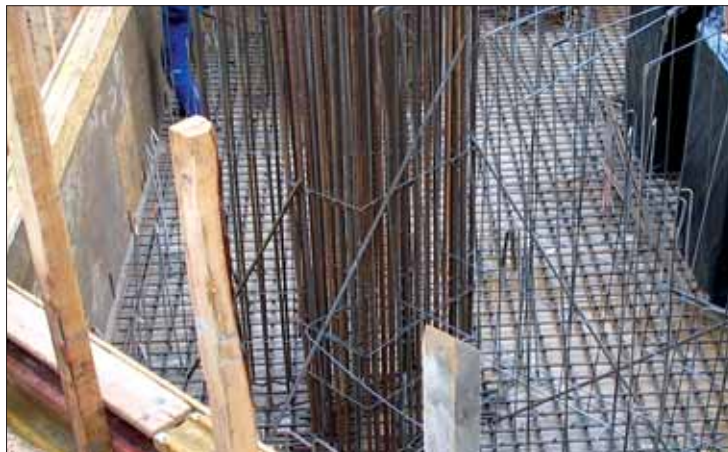
Fragment zbrojenia płyty fundamentu
