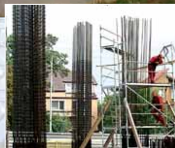
Widoki z wysoka – budowa bramy przy Cerkwi p.w. św. Ducha w Białymstoku – str. 20-21
