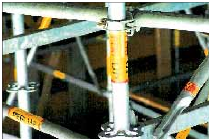
b) typowe rusztowania modułowe
