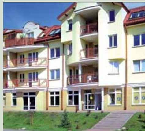
Budynek mieszkalny wielorodzinny przy ul. Przygodnej w Białymstoku, zrealizowany przez firmę Kombinat Budowlany Białystok
