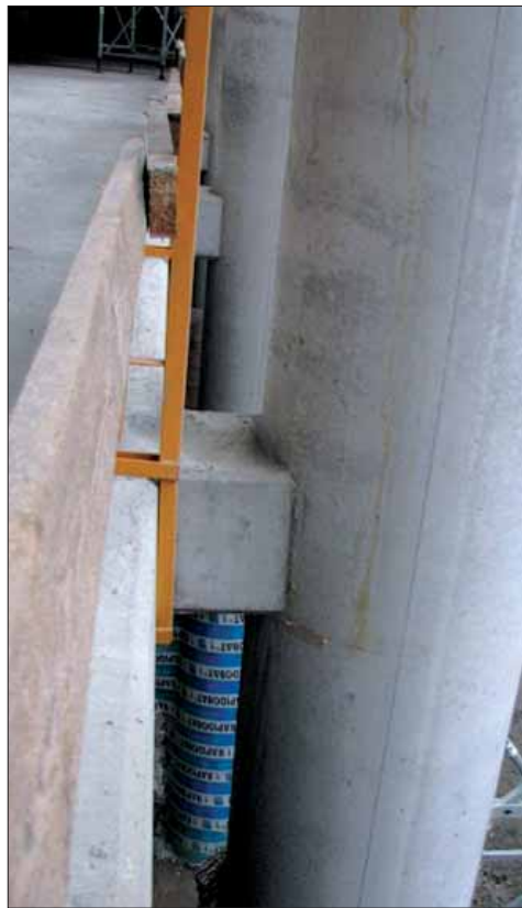
Połączenie słupa ze stropem za pomocą sztywnych wkładów ze stali kształtowej
