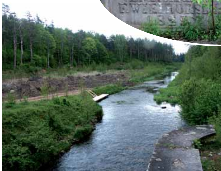
Widok na stronę białoruską przed remontem..
