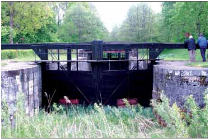
Śluza w Kudrynkach przez rozpoczęciem prac remontowych
