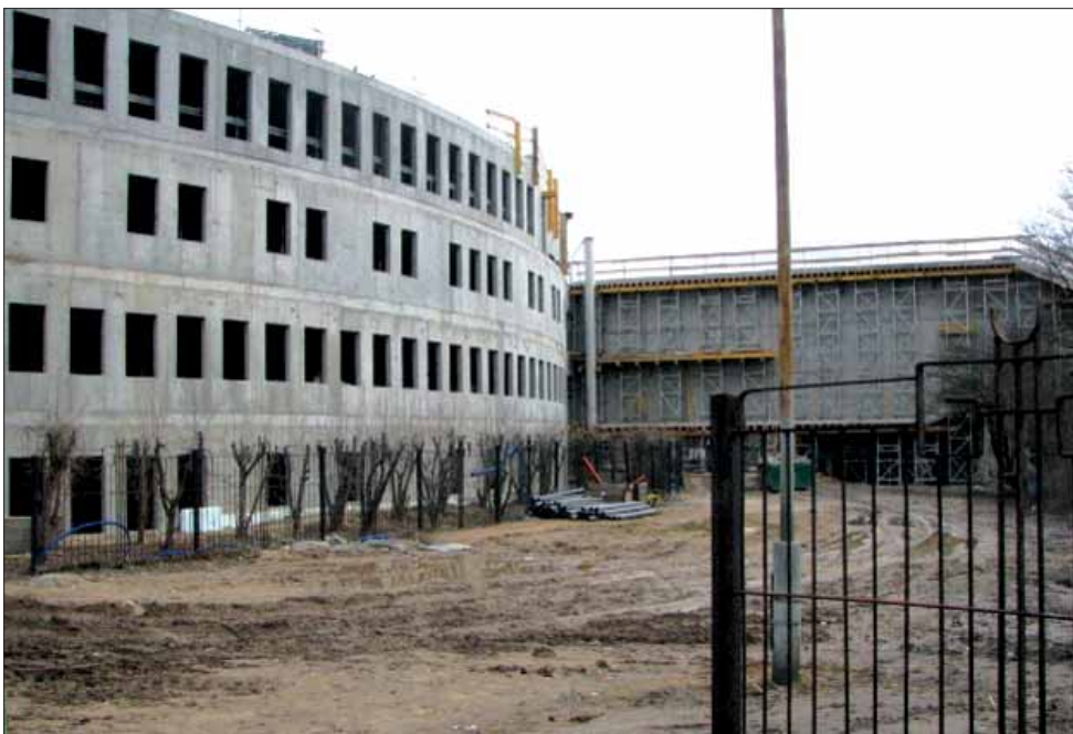
Część administracyjna obiektu, widok na elewację południową
