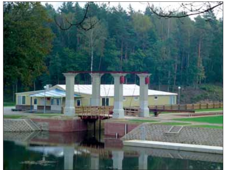
Wyremontowana śluza graniczna w Kurzyńcu z podnoszonym mostem. W dali budynek przejścia granicznego. Brzeg lewy – Białoruś, prawy – Polska
