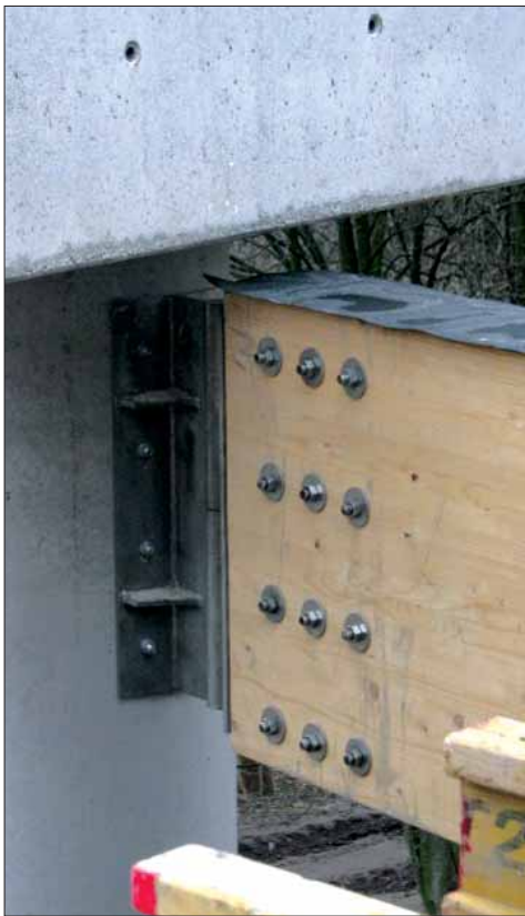
Zawiasy umożliwiające łączenie belek drewnianych do żelbetowych elementów konstrukcji
