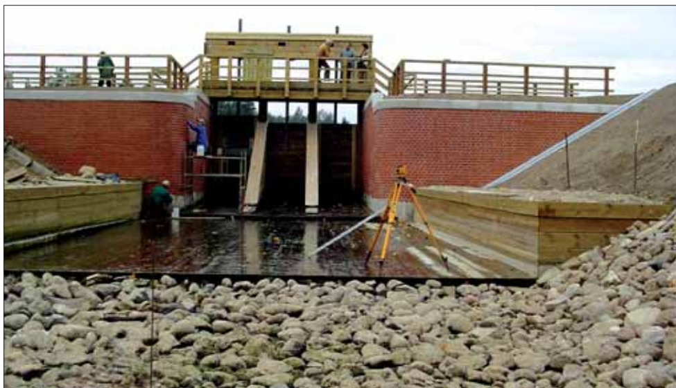
Końcowa faza budowy. Widok na poszur jazu.
