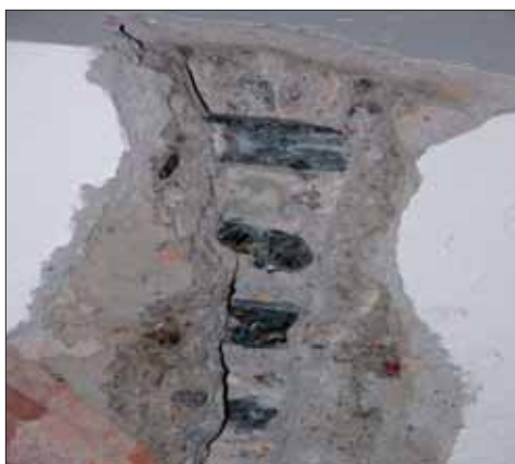
Rys. 6. Fazy procesu badawczego. Wady konstrukcyjne eliminujące poprawne wykorzystanie metody sklerometrycznej
