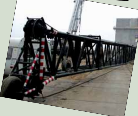
Montaż kratownic - krok po kroku
