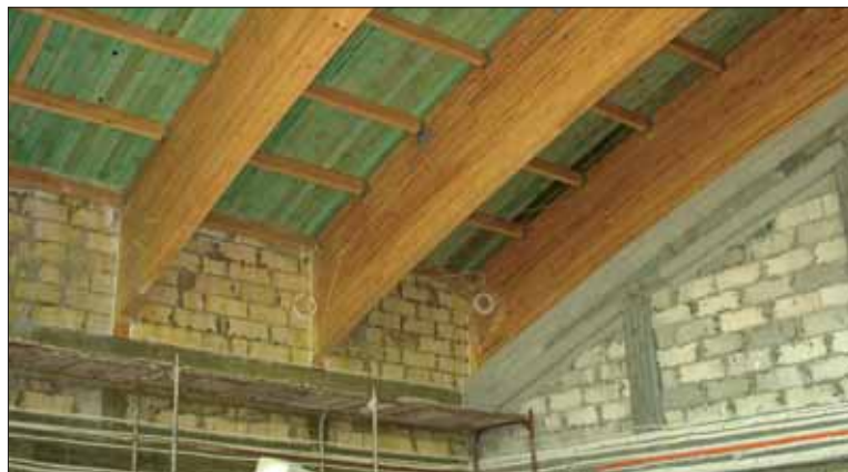
Widok drewnianych dźwigarów wewnątrz obiektu
