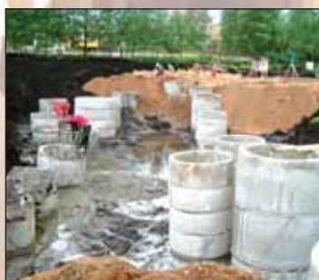
Światelko na trudnym gruncie – Budowa Szkoły Litewskiej w Sejnach ze względu na sposób posadowienia budynku i krótki termin realizacji była bardzo ciekawą inwestycją – str. 16-17
