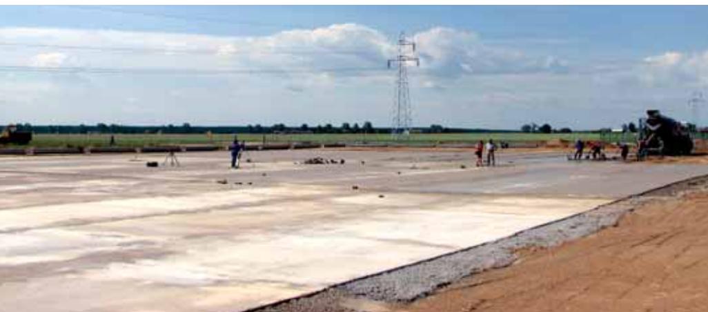
Budynek został posadowiony metodą tradycyjną, na działce wystarczyła częściowa wymiana gruntu
