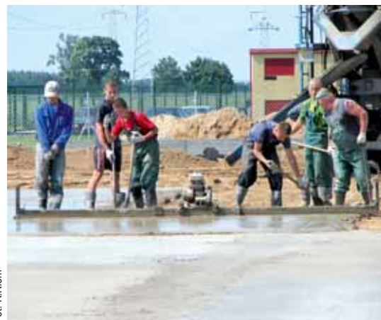
Wylewanie chudego betonu
