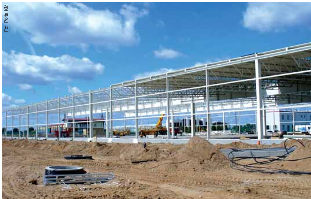
Konstrukcja jest wzniesiona z gotowych prefabrykowanych stalowych elementów
