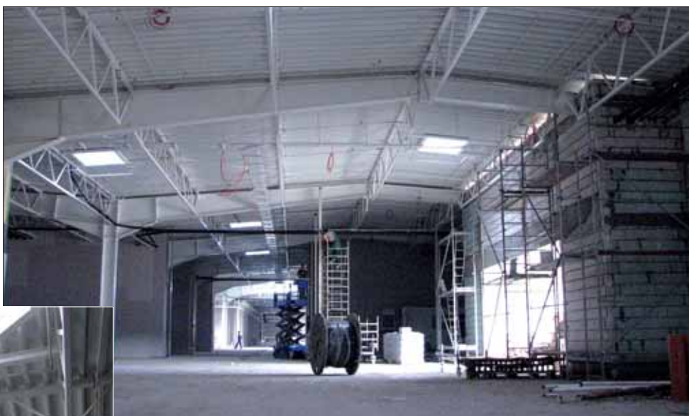
Widok galerii, na razie na etapie budowy
