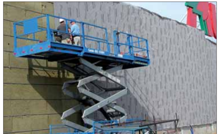
Prace przy wykonywaniu elewacji: docieplanie wełną mineralną i układanie kasetonów elewacyjnych
