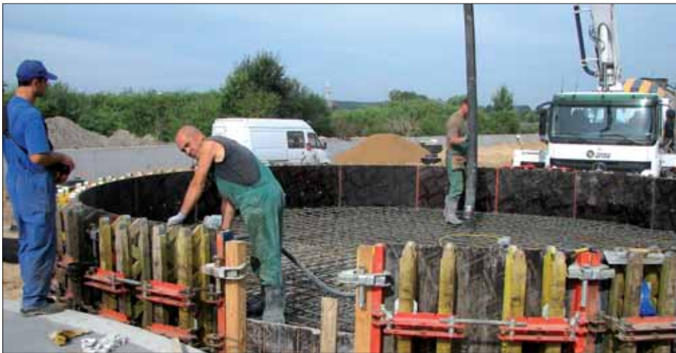
Betonowanie fundamentu pod budowę zbiornika pożarowego
