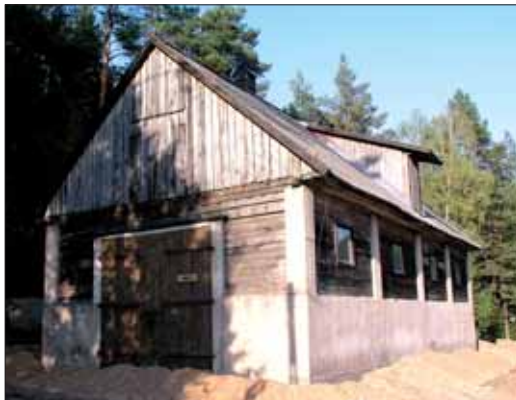
Budynek przed i po modernizacji
