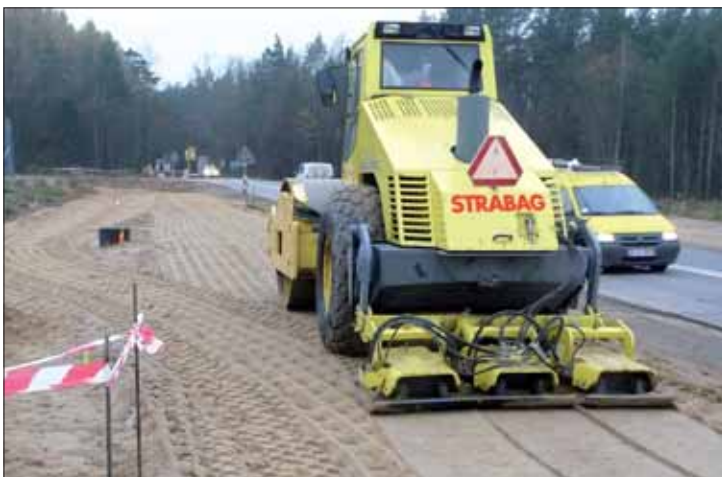
Wykonywanie warstw nasypu
