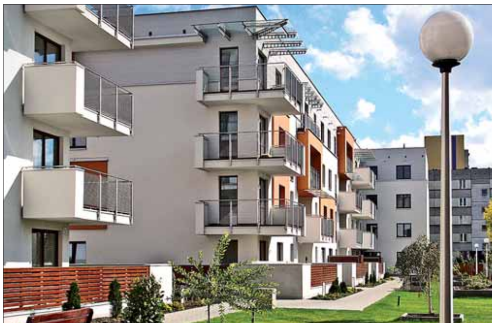
Zespół zabudowy mieszkaniowej wielorodzinnej w Białymstoku przy ul. Kraszewskiego 28 i 28B
