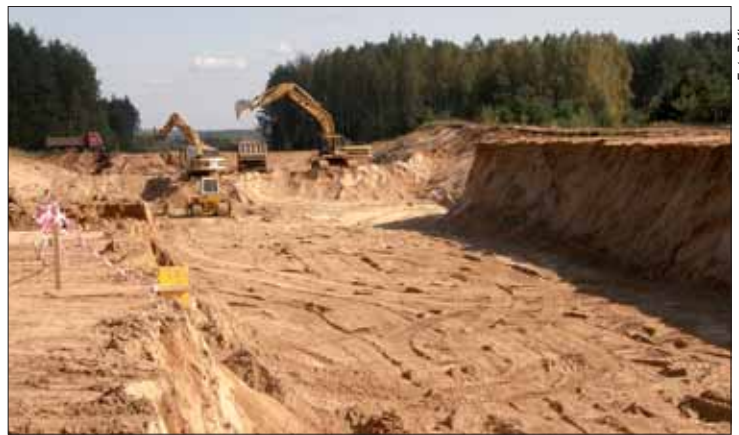
Investycja nazwana przebudową w większości prac jest typową budową drogi od podstaw. Na zdjęciu widać korytowanie pod jedną nitką jezdni kilka kilometrów za Jurowcami, jadąc w stronę Katryнки.
