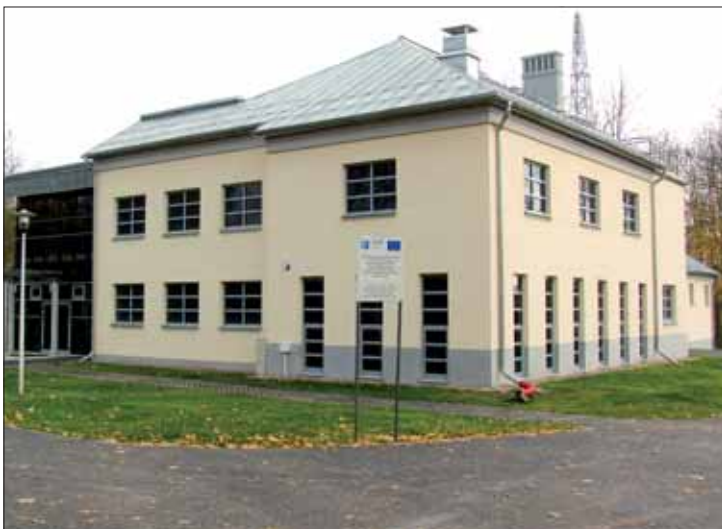
Budynek po remoncie z zagospodarowanym placem
