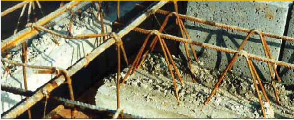
Rys. 8. Strop Teriva-I BIS – strefa wieńca w trakcie realizacji
