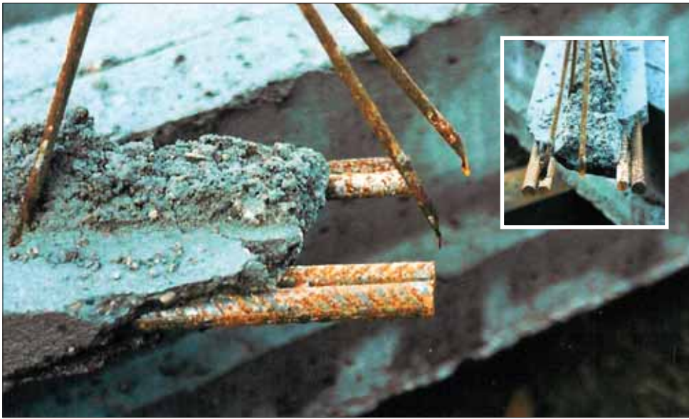
Rys. 5. Zbrojenie prefabrykowanych belek w strefie podporowej
