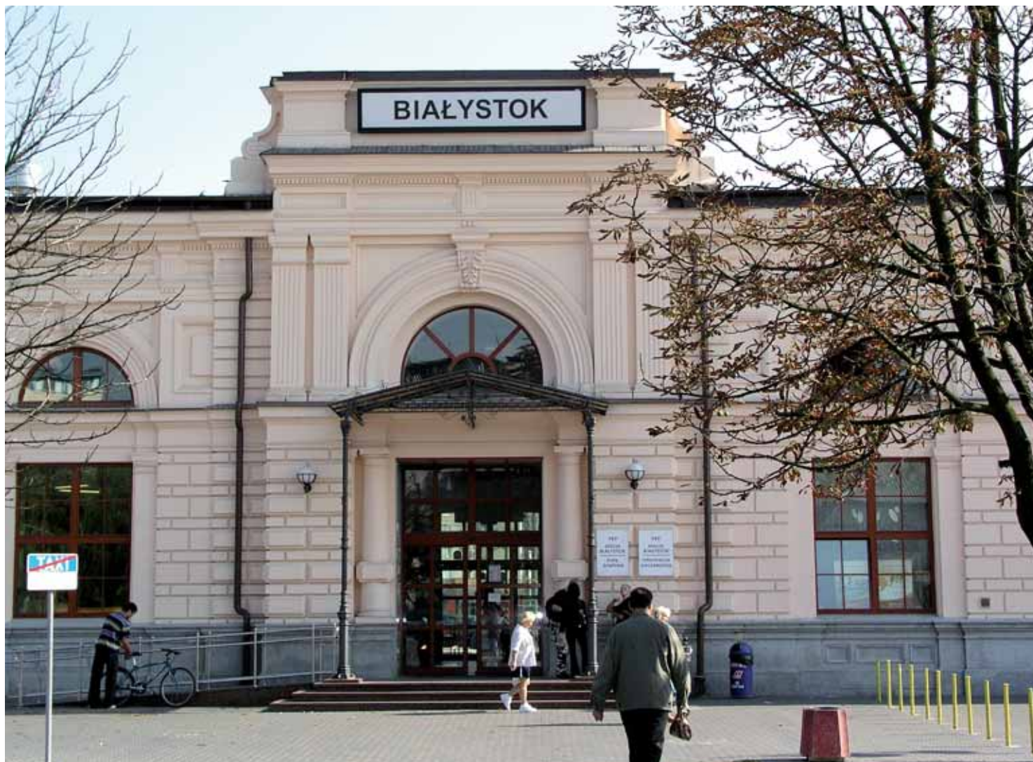
Dworzec kolejowy znów stał się jednym z najbardziej reprezentacyjnych budynków Białegostoku
