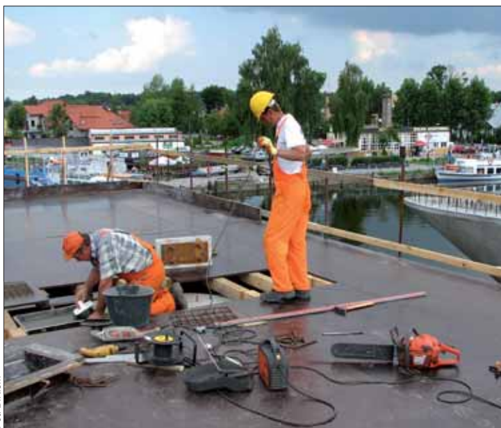
Układanie blatów tworzących deskowanie pod betonowanie kładki
