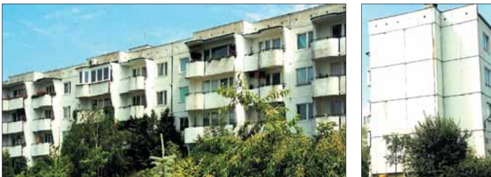
Rys. 1. Fragmenty elewacji budynku wykonanego w technologii Wk-70
