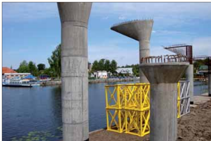
Konstrukcja wsporników pochylni od strony rzeki Netty
