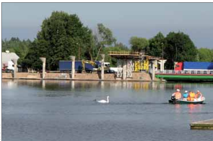
Widok na plac budowy od strony zachodniej
