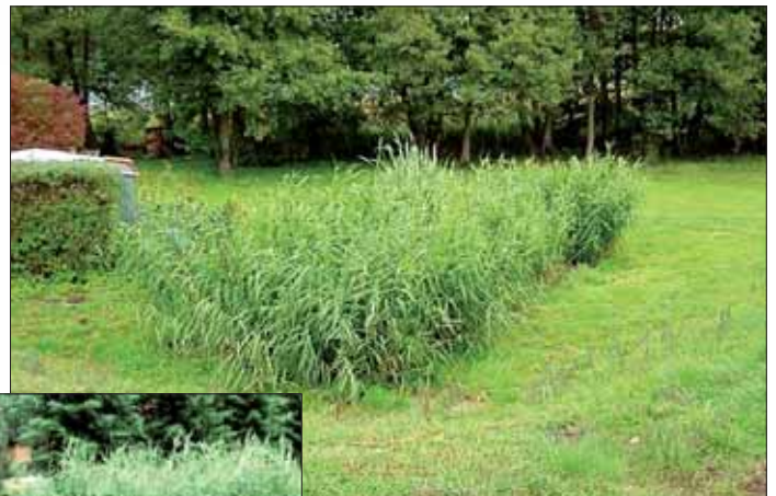
Jedyny widoczny element oczyszczalni to roślinność porastająca filtr
