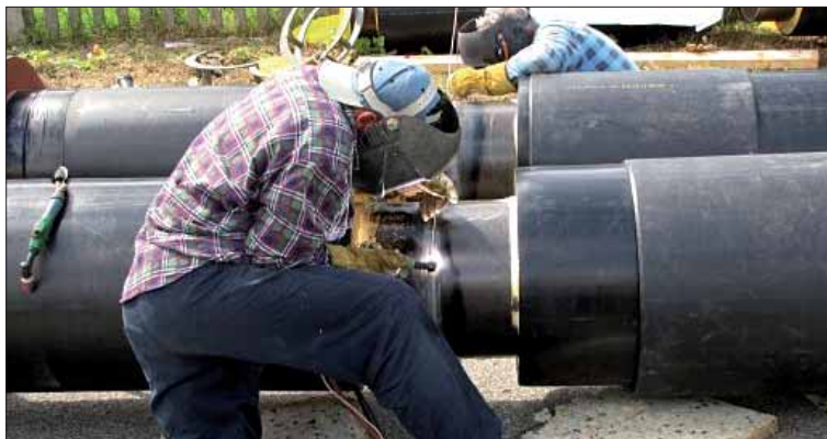
Łączenie rur preizolowanych przy ul. Sławińskiego. Stan robót z wakacji 2009 r.
