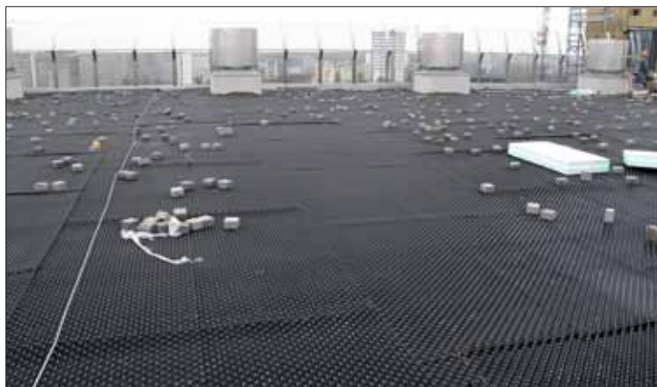
Pierwsze warstwy dachu zielonego
