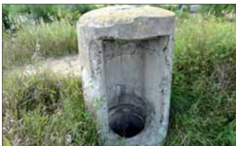
Zdjęcie Nr 2. Obudowany wlot do zbiornika na wodę w górze wału
