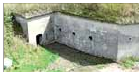
Zdjęcie Nr 5. Artyleryjska kaponiera umieszczona w przeciwskarpie
