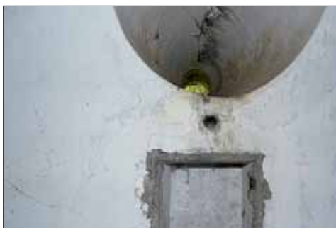
Zdjęcie Nr 3. System oświetlenia. Okrągły otwór-wlot światła słonecznego. Poniżej 2 małe otwory to miejsce po zamocowanym lustrze. Niżej kwadratowy otwór, to miejsce na latarnię w porze nocnej.
