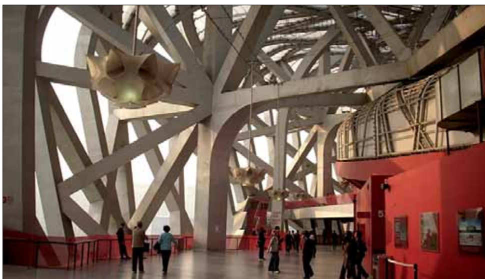
Fragment konstrukcji stadionu
