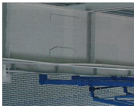
Rys. 9. Żebro wzmocniające stateczność dźwigarów stalowych. Wzmocnienia połączeń czołowych elementów dźwigarów IKS
