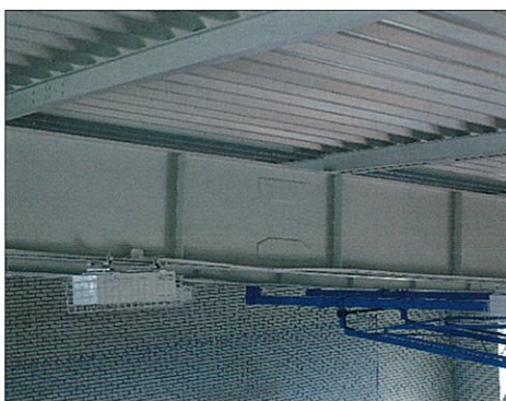
Rys. 9. Żebro wzmocniające stateczność dźwigarów stalowych. Wzmocnienia połączeń czołowych elementów dźwigarów IKS
