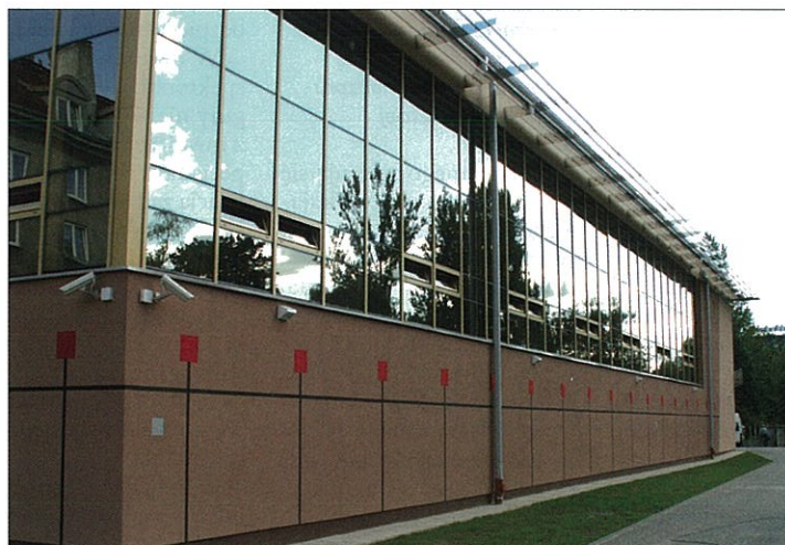
III miejsce – budowa sali gimnastycznej przy VI Liceum Ogólnokształcącym w Białymstoku
