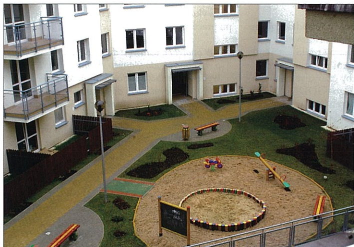
II miejsce – budowa budynku mieszkalnego wielorodzinnego w Białymstoku przy ul. Wrocławskiej
