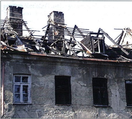
Rys. 1. Konstrukcje dachowe zniszczone w efekcie pożaru i akcji gaśniczych
