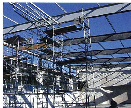
Rys. 7. Etapy realizacji prac rozbiórkowych, usuwanie zdegradowanych elementów
