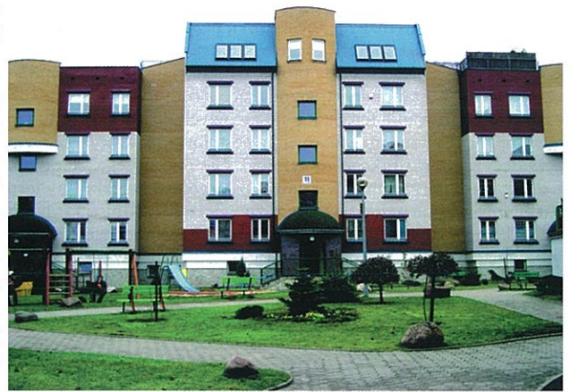
Kolorowe, elewacyjne cegły silikatowe w budownictwie wielorodzinnym
