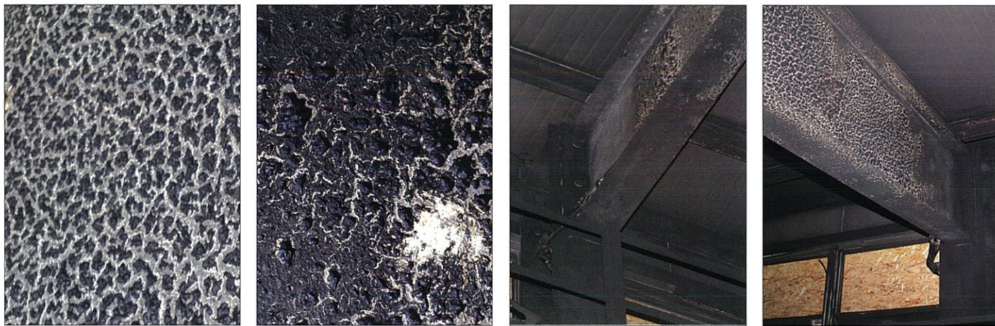
Rys. 5. Efekt działania temperatury pożaru na powierzchni stalowe
