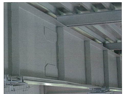
Rys. 9. Żebro wzmocniające stateczność dźwigarów stalowych. Wzmocnienia połączeń czołowych elementów dźwigarów IKS
