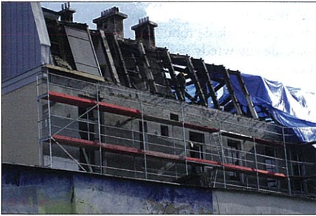
Rys. 1. Konstrukcje dachowe zniszczone w efekcie pożaru i akcji gaśniczych
