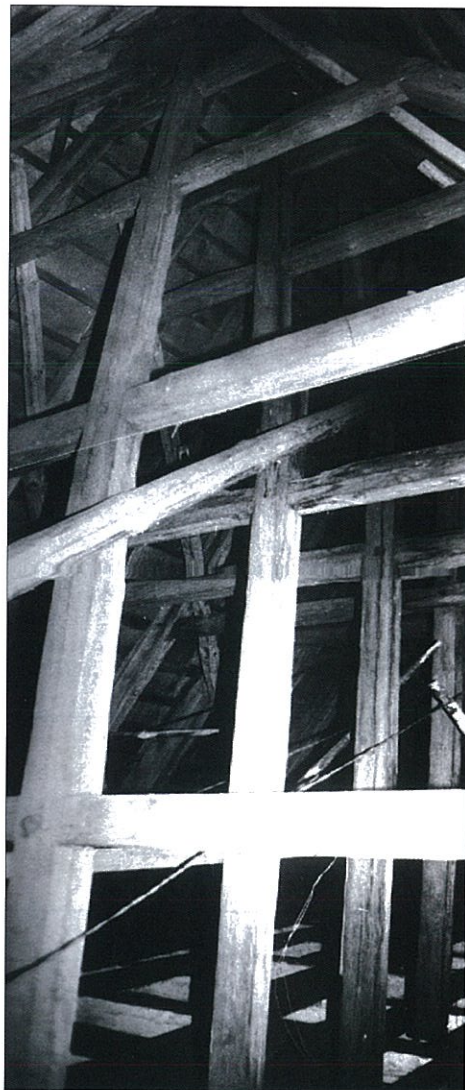
Rys. 6. Widok czterojętkowej więźby obiektu w Kamiennej Starej.
