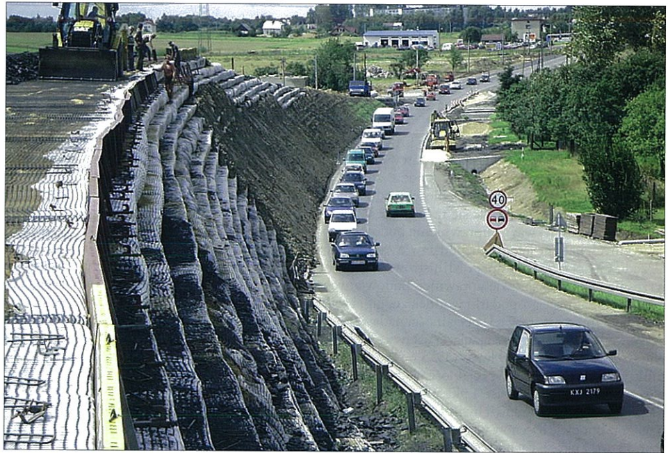
Formowanie kolejnej warstwy zbrojącej konstrukcję nasypu
