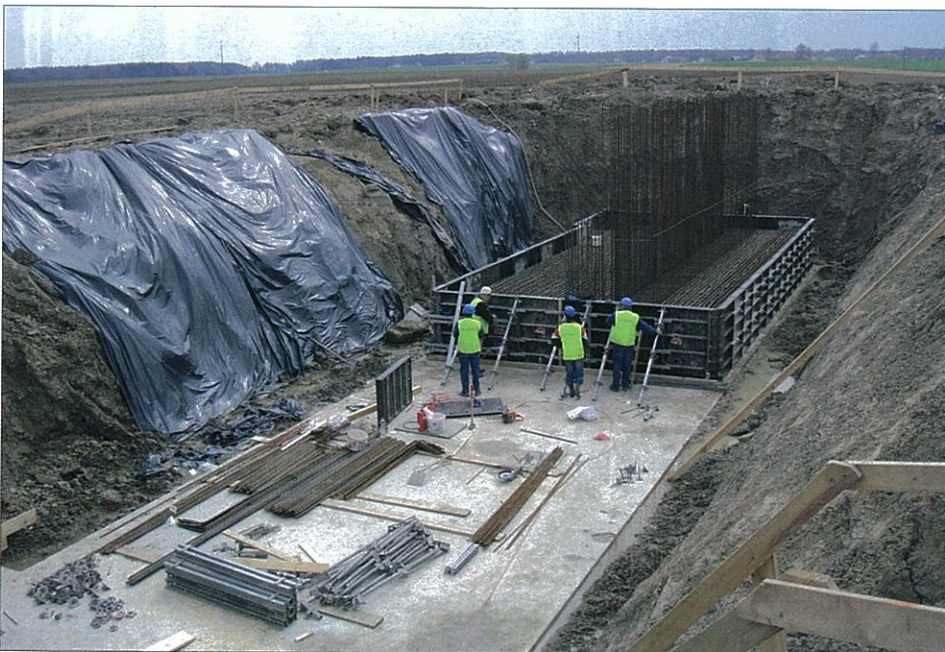
WS 7 – fundamenty pod węzeł Wiśniewo
