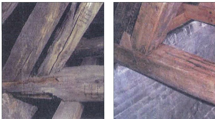
a) – stan drewna przed wzmocnieniem, b) belka po wzmocnieniu.
