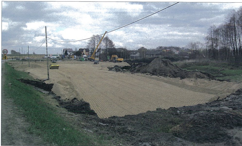
Wymiana gruntu przy rzece Jabłonka
