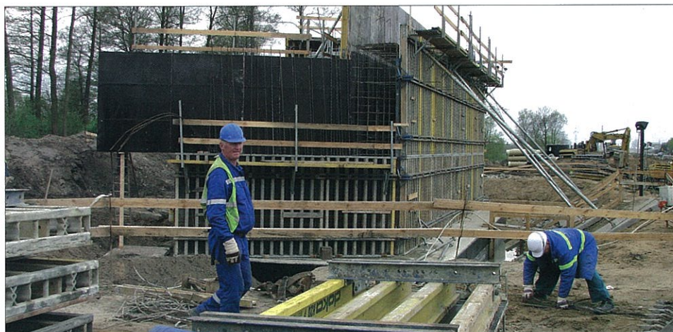
Tu oparty będzie wiadukt łukowy w ciągu ul. Lodowej nad ul. Maczka, tzw. „łuk białostocki”
