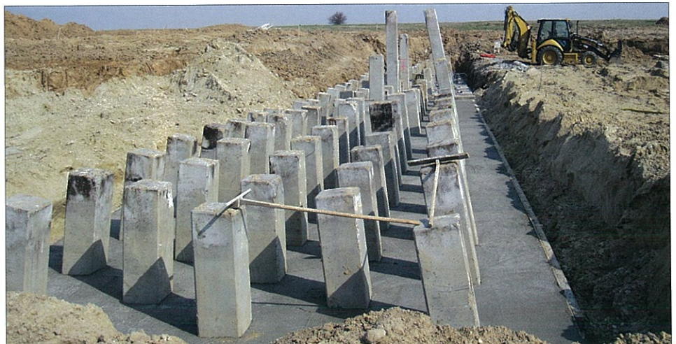
WD 13 – węzeł Zambrów, wbite prefabrykowane pale żelbetowe pod podporę wiaduktu
