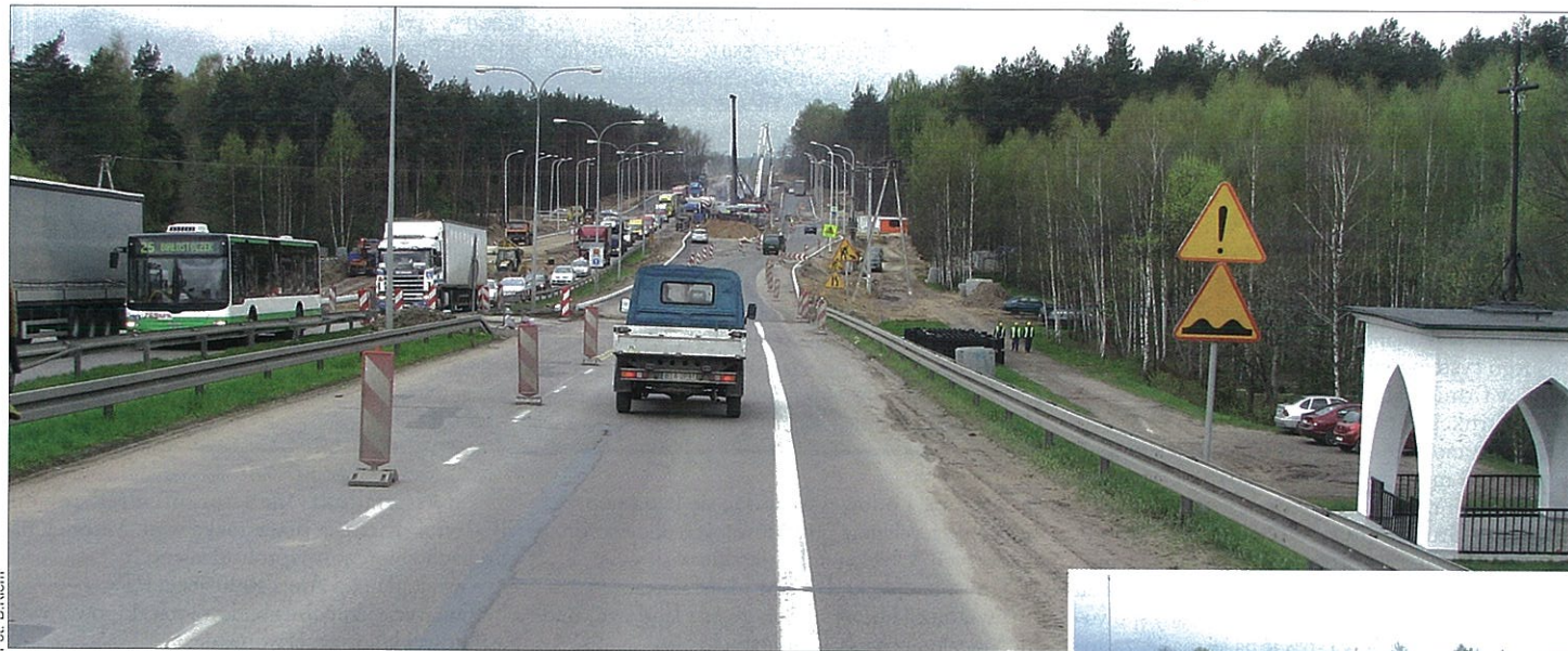
Widok na miejsce, gdzie powstaje węzeł ul. Maczka z ul. Świętokrzyską
