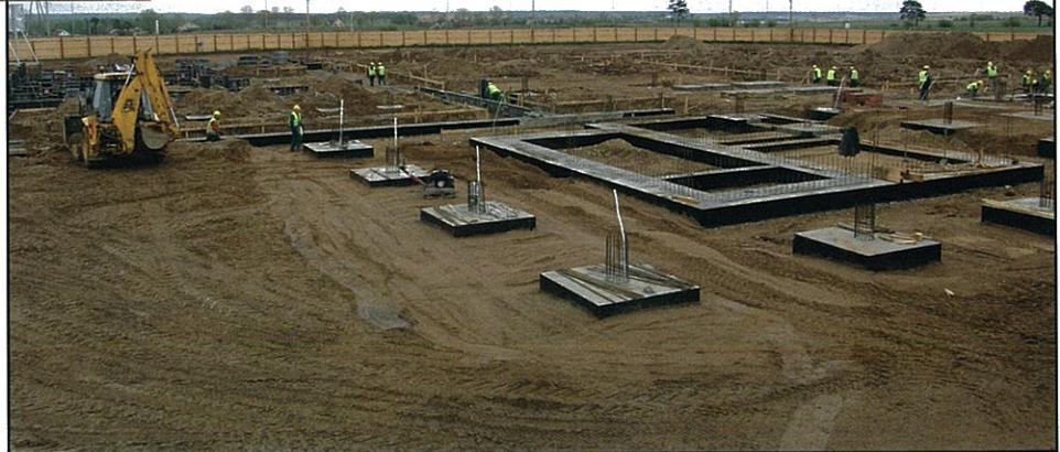
Tworząc Biuletyn odwiedzam często budowy, tu – muszę przyznać – zastałam zaskakujący ład i porządek. Na zdjęciu obok Marek Żebrowski, kierownik budowy z ramienia generalnego wykonawcy firmy PRIBO Suwałki
