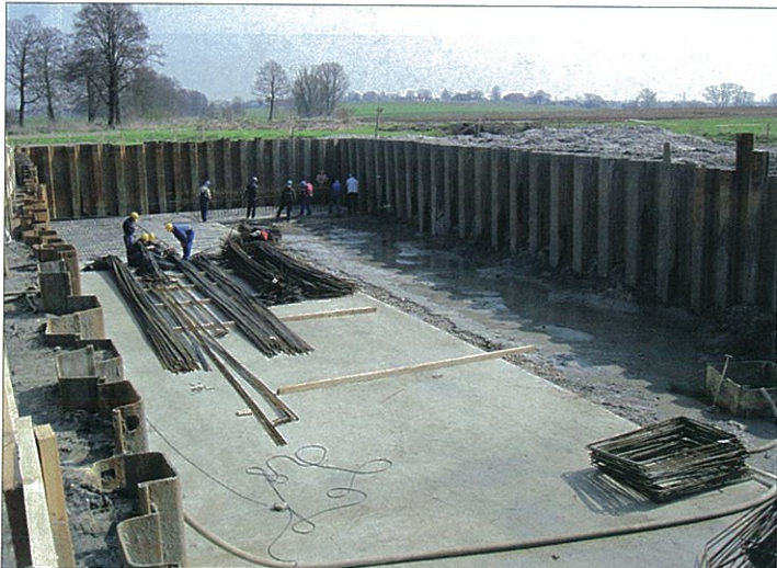
Fundamenty na rzece Prądnik – droga nr 63 obiekt mostowy nr 13
