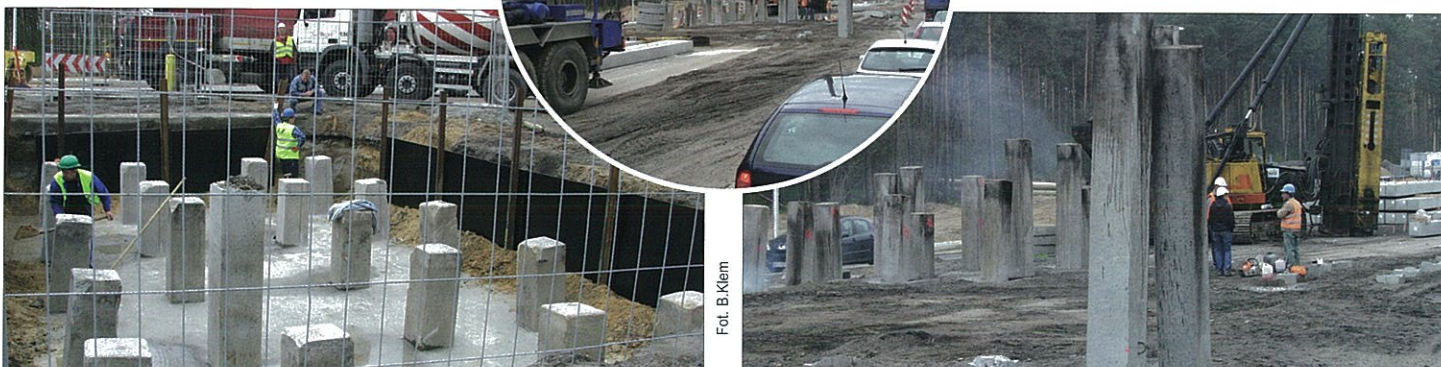
Budowane estakady są obiektami posadowionym na palach prefabrykowanych wbijanych techniką pograżania
