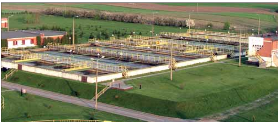
Komory nityfikacji i denityfikacji na oczyszczalni ścieków w Suwałkach
