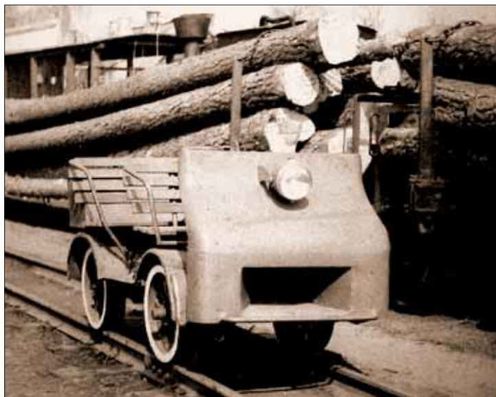
Dreznina inspekcyjna na terenie stacji leśnej kolei wąskotorowej w Płocicznie. Lata siedemdziesiąte XX wieku.
