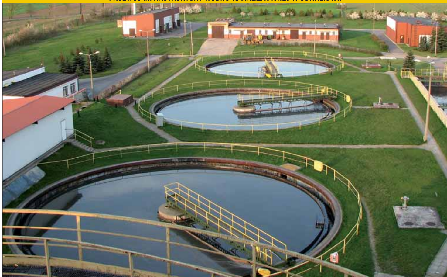
Osadniki wstępne na oczyszczalni ścieków w Suwałkach
