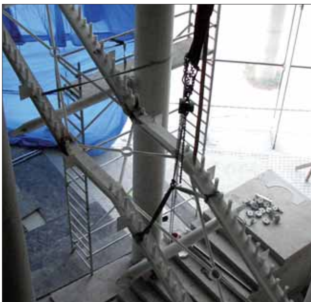
Konstrukcja przygotowana pod szklane schody
