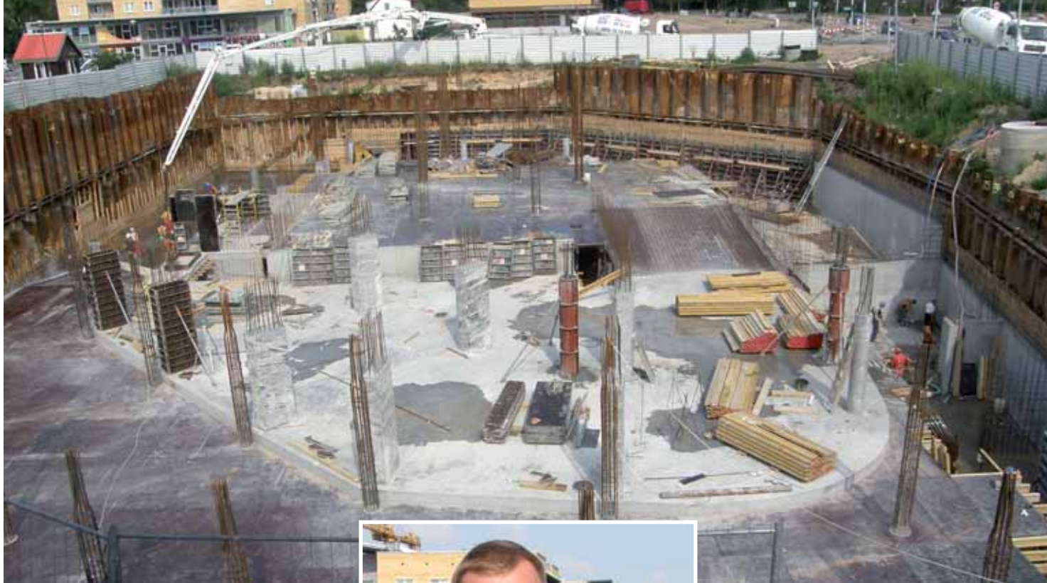
Widok na wakacyjny plac budowy
