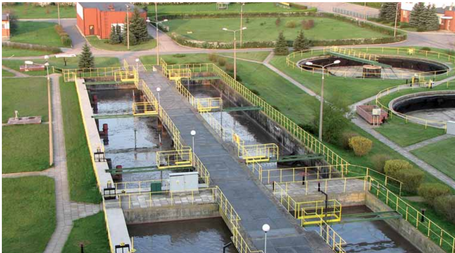
Komory defosfatacji na oczyszczalni ścieków w Suwałkach
