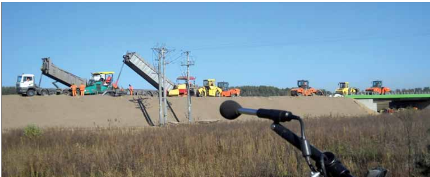
Pomiary hałasu od robót drogowych (budowa obwodnicy Wasilkowa – dolina rzeki Czarna)
