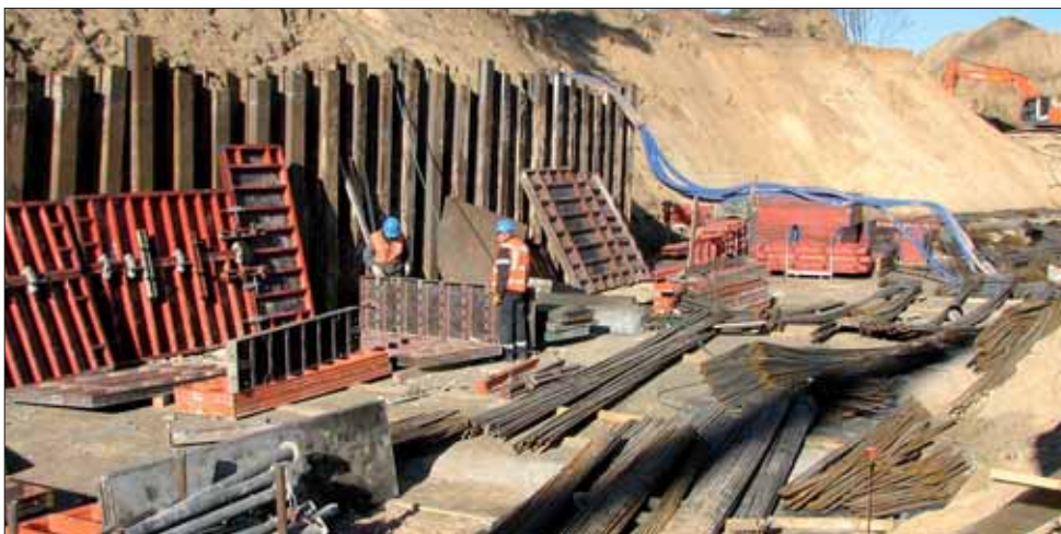
Wjazd do podziemnych parkingów od strony ul. Ciołkowskiego
