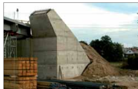
Blok oporowy oczekujący na zamontowanie jednego z brzegów łuku
