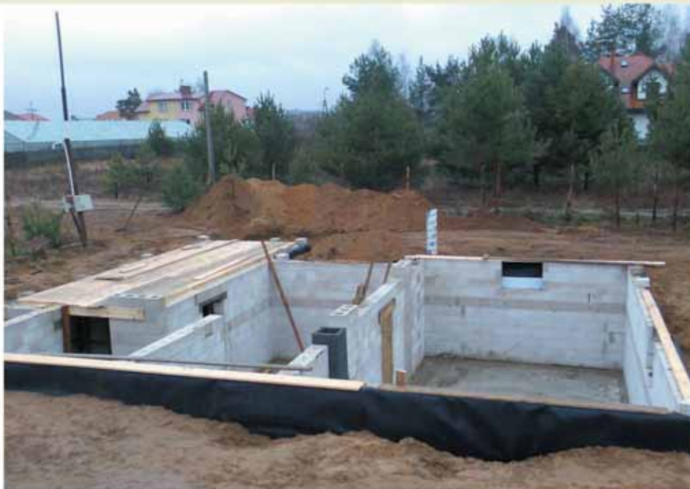
Ściany piwnic wykonane z silikatu
