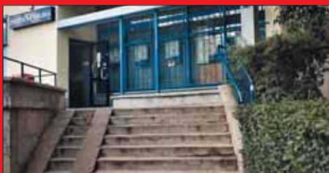
Urząd Pocztowy przy ul. Bema w Białymstoku z podjazdem o nachyleniu 50%, zupełnie nieprzydatnym dla osób niepełnosprawnych.
