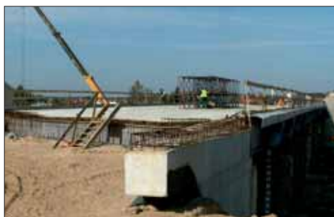
Gotowa płyta jezdni po zazbrojeniu i zalaniu betonem
