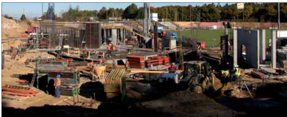
Widok na plac budowy od strony bazaru
