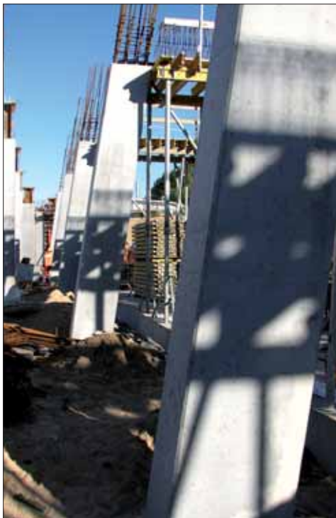
Słupy konstrukcyjne wykonane z betonu licowego
