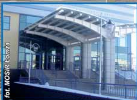
Pływalnia miejska w Łomży
