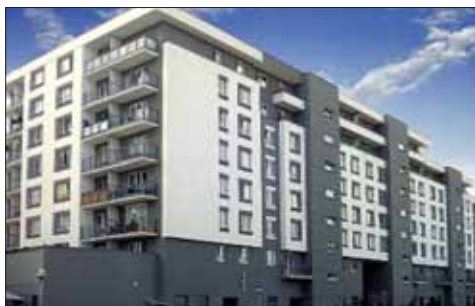
Budynek przy ul. Antoniukowskiej 56
