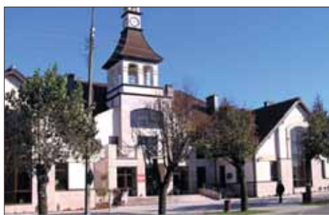
Budynek Urzędu Miejskiego w Michałowie
