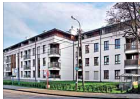
Budynek mieszkalny przy ul. Św. A. Boboli 3A
