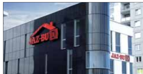
Budynek biurowo-usługowy przy ul. Świętokrzyskiej
