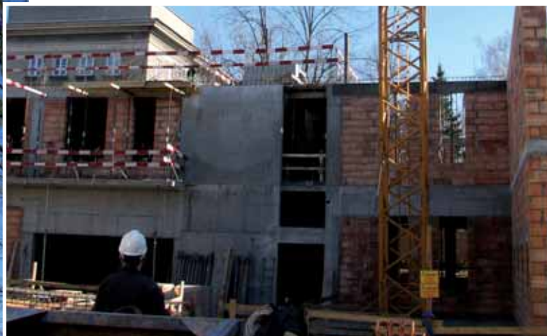
Pod koniec kwietnia na budowie szalowano strop nad pierwszym piętrem budynku. Widok na budynek od „podwórka”.
