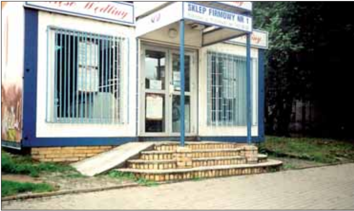
Zdjęcie 1. Sklep firmowy Zakładów Mięśnych ze stromym podjazdem nieprzydatnym dla wózków. Strone schody bez poręczy są trudne do pokonania przez ludzi starszych.
