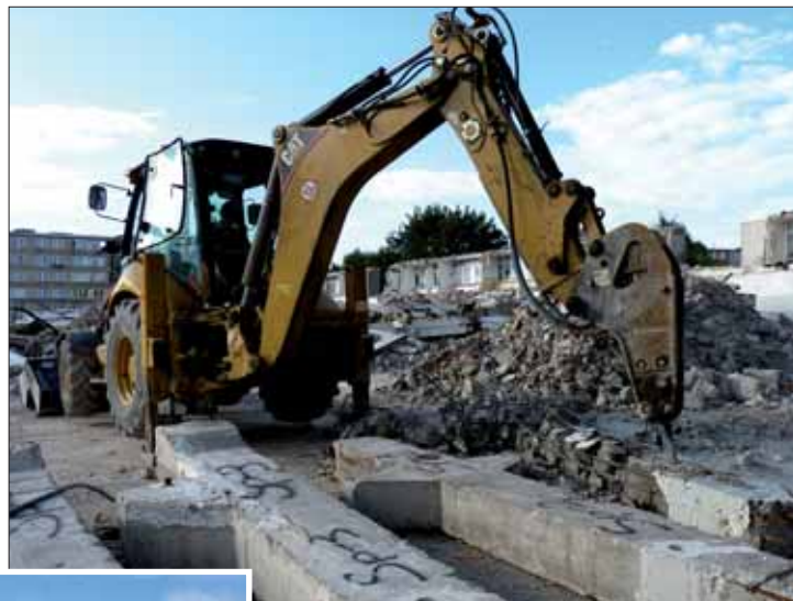
Proces wstępnego kruszenia słupów prefabrykowanych
