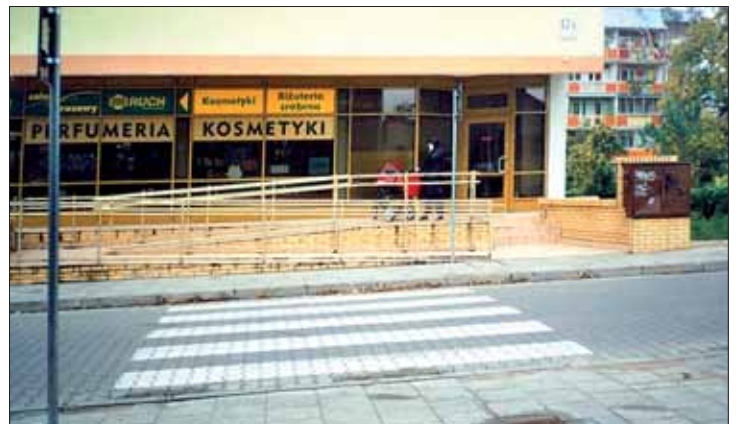
Zdjęcie 5. Drogi dojazdowe do osiedli mieszkaniowych przecinają chodnik przy ul. Mieszka I. Wysokie krawężniki są poważną przeszkodą dla wózków inwalidzkich i dziecięcych. Kto ma obniżyć te krawężniki i udroźnić chodnik? Takich miejsc jest w mieście bardzo dużo.
