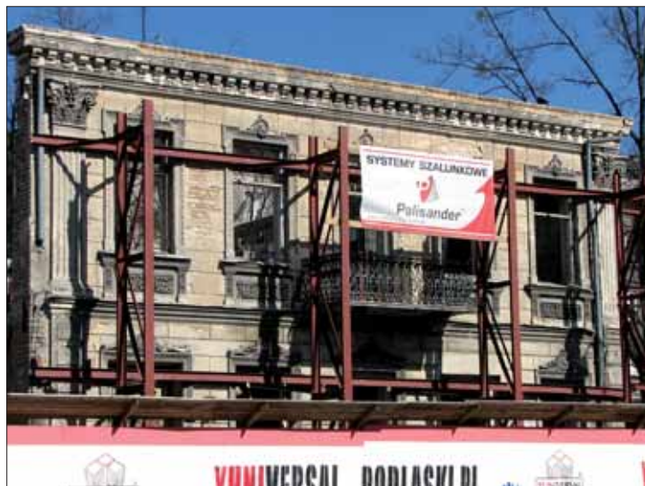
Szczegółowy widok na zabezpieczoną ścianę zabytkowego Domu Wellerów
