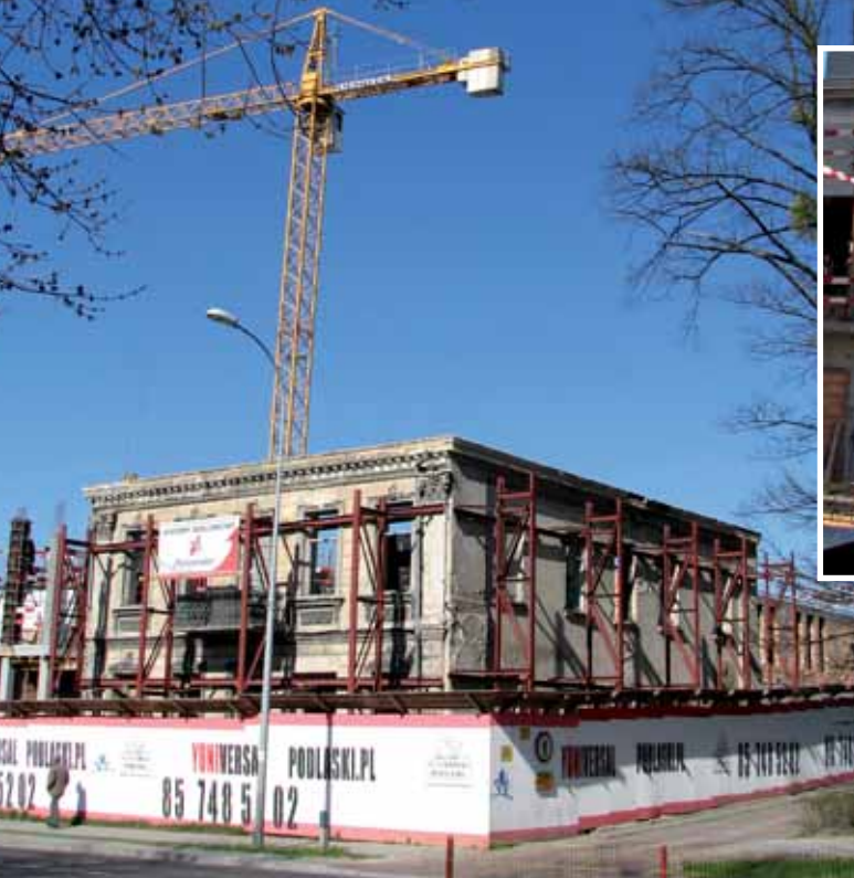
Widok na wiosenny plac budowy od strony ul. Sienkiewicza
