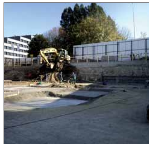
Przygotowanie płyty fundamentowej kotwionej w ścianie szczelinowej
