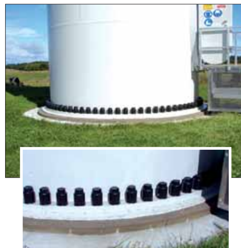
Rys.13.Układ śrub kotwiących wież w Jeleniewie.
