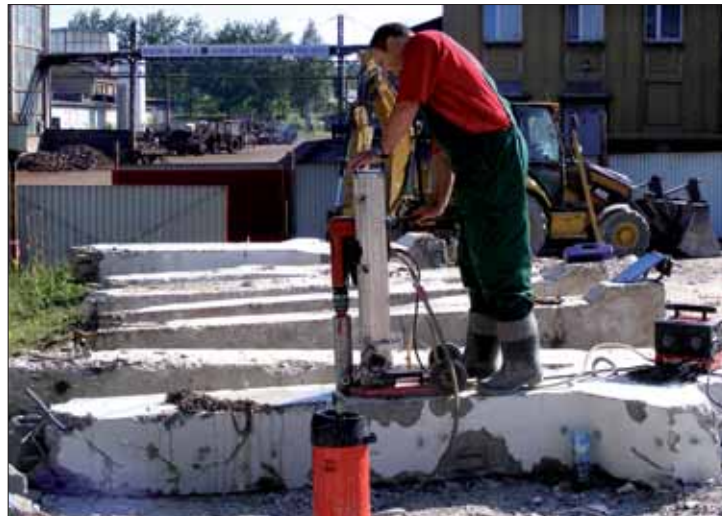
Odwierty rdzeniowe w słupach prefabrykowanych
