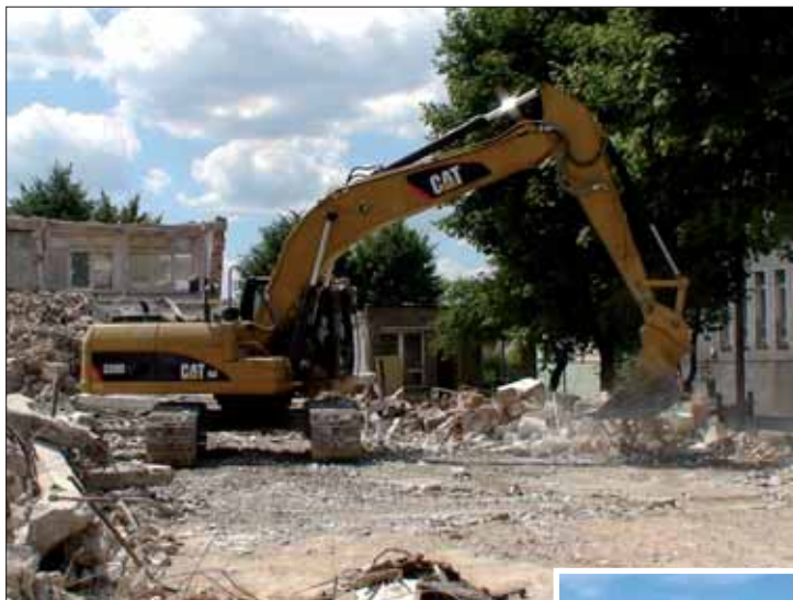
Prace rozbiórkowe hali i budynku socjalnego na „Uchwytach”
