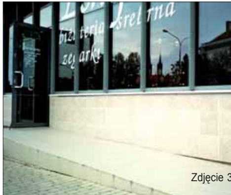
Zdjęcie 1. Sklep firmowy Zakładów Mięśnych ze stromym podjazdem nieprzydatnym dla wózków. Strone schody bez poręczy są trudne do pokonania przez ludzi starszych.
