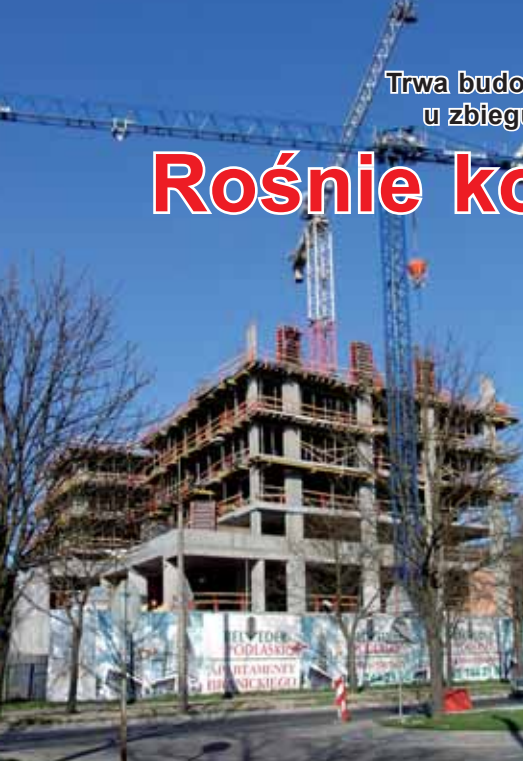
Obecny stan budowy
