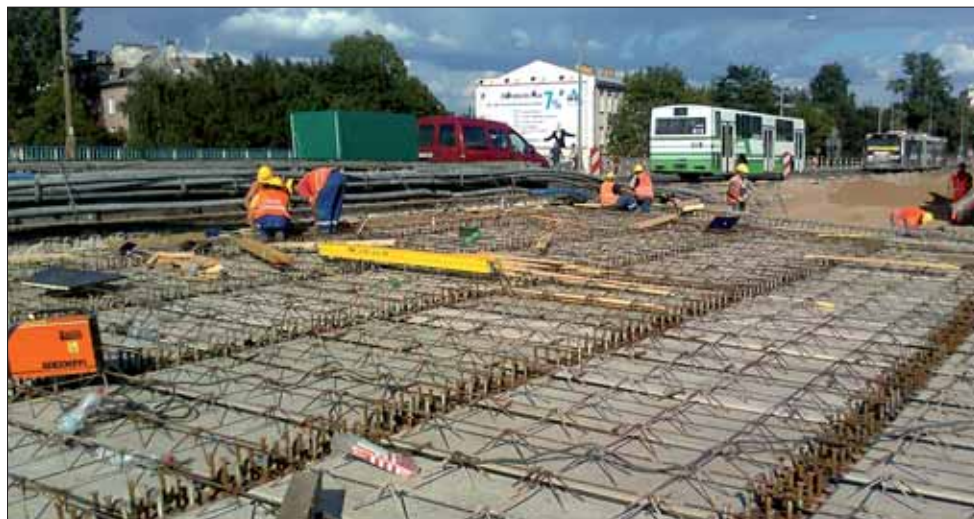
Na dźwigarach były układane płyty typu filigran w trzech długościach: 0,86, 1,02 i 1,80 m o szerokości 80cm.
