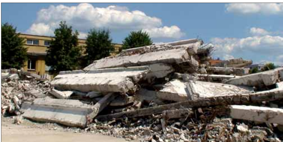
Fot.1 Miejsce rozbiórki obiektu o konstrukcji monolitycznej
