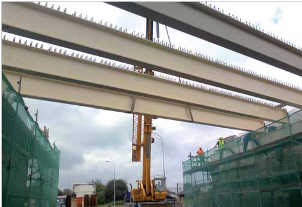
W ostatni weekend lipca na placu budowy odbywał się montaż konstrukcji stalowej wiaduktu
