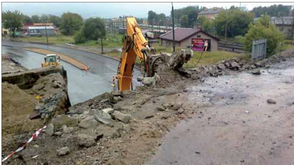
Stary wiadukt został rozebrany
