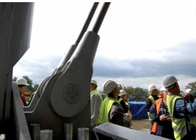
Wielkie elementy kotwiące konstrukcję dachu sprowadzono z Włoch
