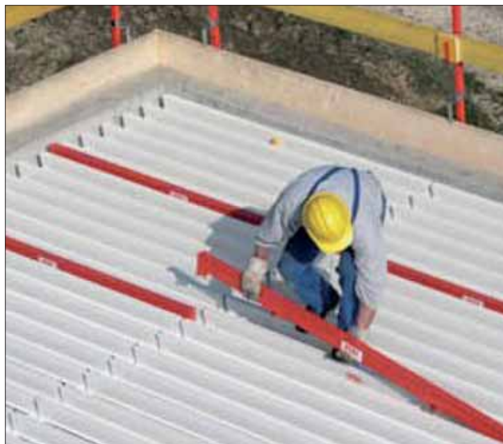
b) montaż dźwigarów wczesnego rozdeskowania (GFB)
