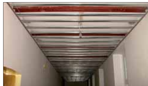
Widok elementów wzmacniających na poddaszu
