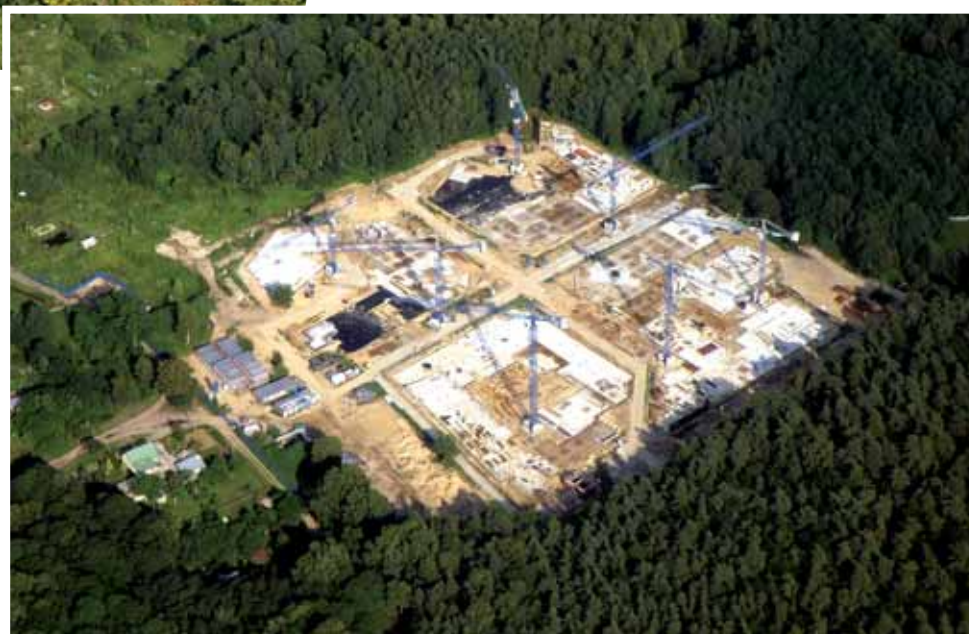
Widok na plac budowy z lotu ptaka
