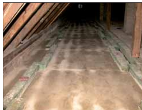
Widok wzmocnień (wraz z elementami sufitu podwieszonego osłaniającego konstrukcję wzmacniającą) w części korytarzowej
