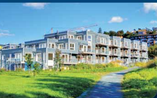
Osiedle Bergheim Plass w Trondheim, Norwegia ↙ budownictwo modułowe
