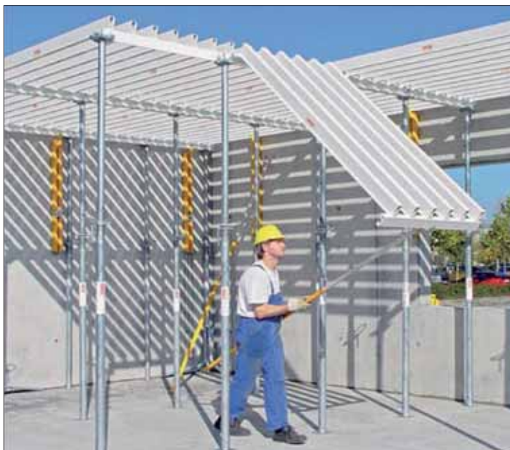
Rys. 1. Deskowanie rusztowe Gridflex; a) montaż rusztu (GFP),
