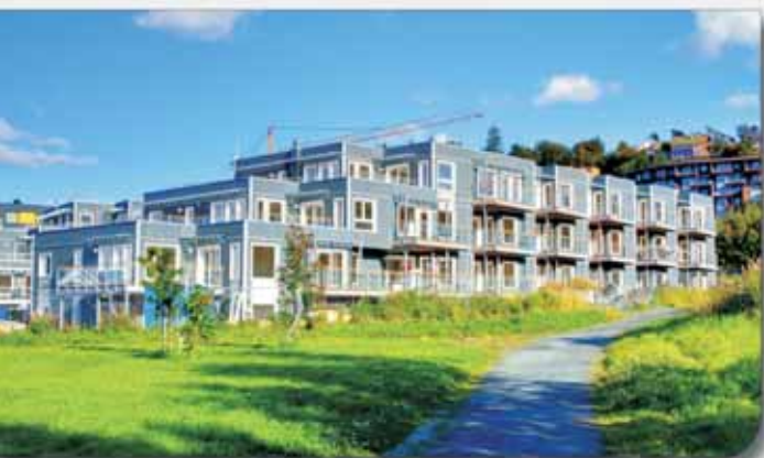
Osiedle Bergheim Plass w Trondheim, Norwegia ↗ budownictwo modułowe
