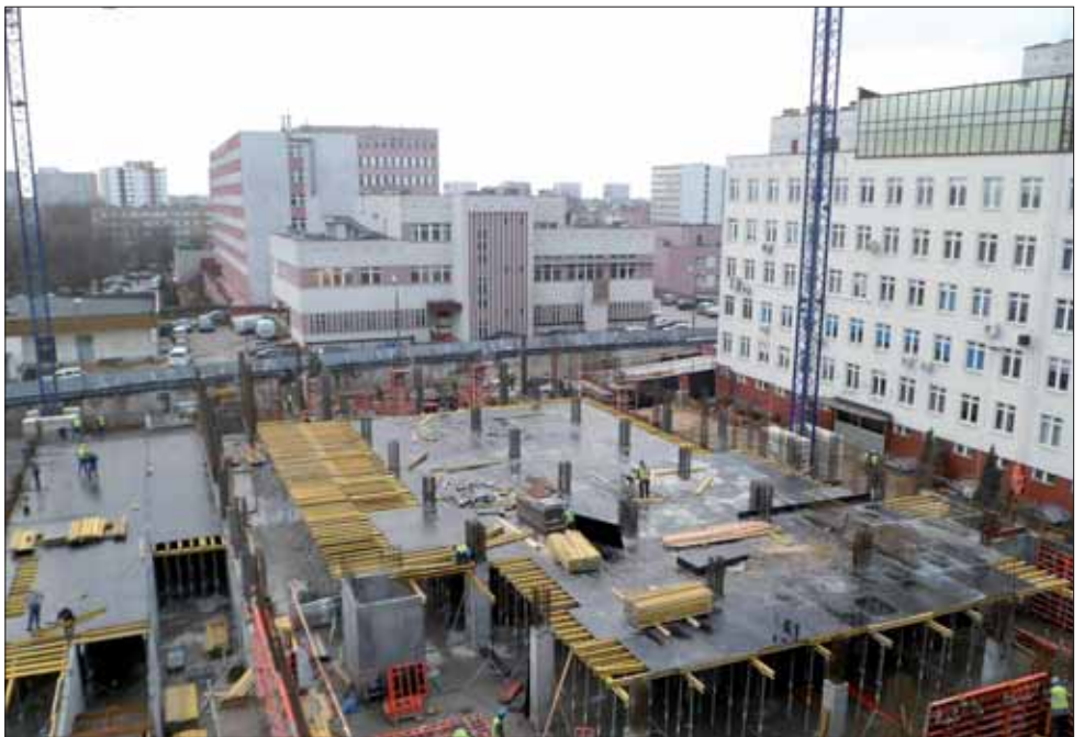
Uniwersytecki Szpital Kliniczny w Białymstoku – stan realizacji inwestycji ze stycznia 2012 r.
