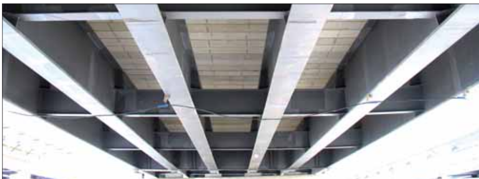
Widok na płyty filigranowe, stanowiące szalunek tracony
