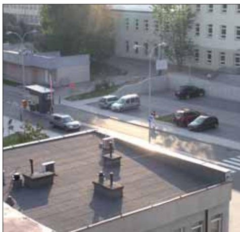
W 2011 r. wykonany został nowy wjazd na teren szpitala od strony ul. M. Skłodowskiej
