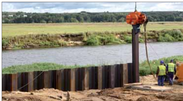
Wbijanie ścianek szczelnych, które okalają cały port i marinę
