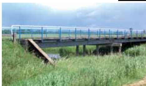
Widok z boku starego mostu
