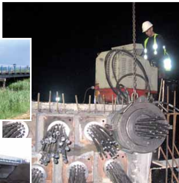
Po betonowaniu bloki kotwiące zostały rozszalowane i wykonano sprężanie konstrukcji
