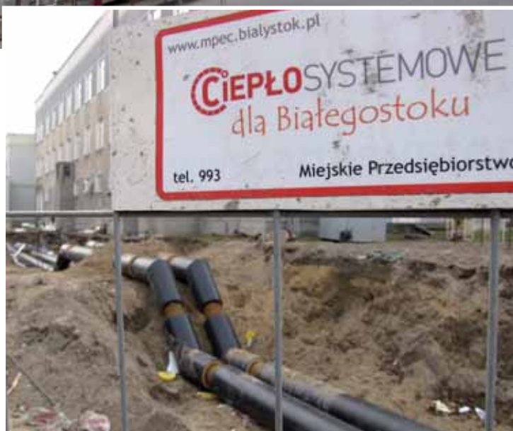
Prace przy budowie sieci od strony północno-zachodniej szpitala
