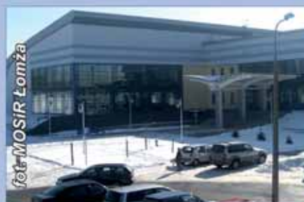
Pływalnia Miejska w Łomży
