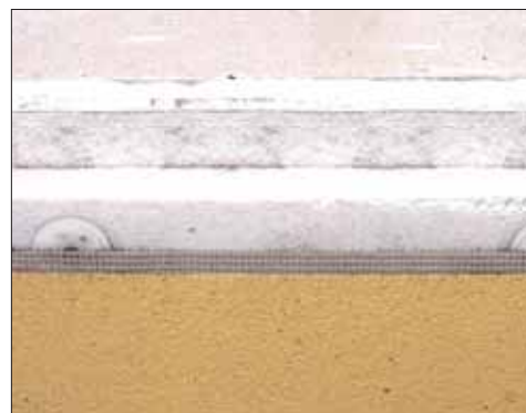
Dodatkowa warstwa izolacji ściany na istniejącym już ociepleniu - BOLIX DOUBLE THERM
