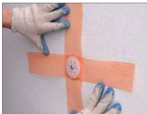
Sposób wykonania mocowania KWM
