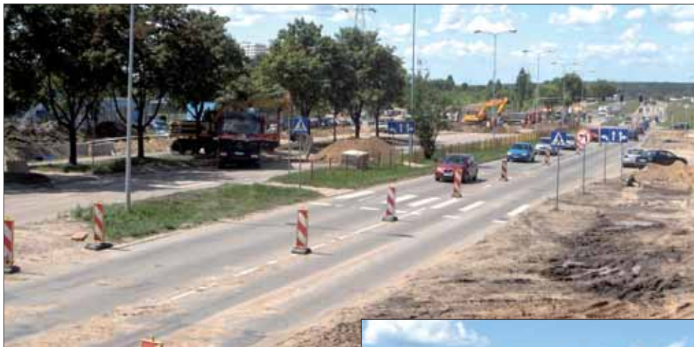
Widok na plac budowy z początku lipca
