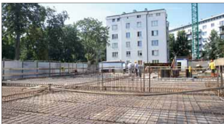
Stan budowy z końca lipca br.
