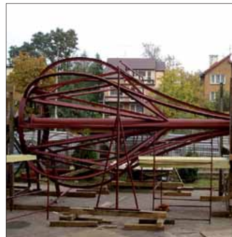
Szkielet stalowy konstrukcji kopuły.
