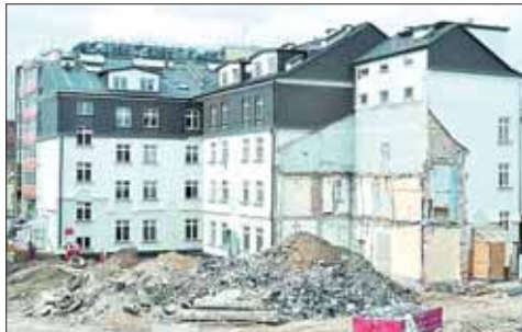
Rys. 1 Istniejący budynek – widok na plac budowy przed realizacją prac
