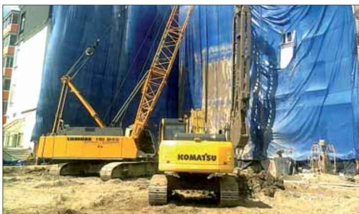
Rys. 7 Głębienie ścian szczelinowych przy istniejącym budynku
