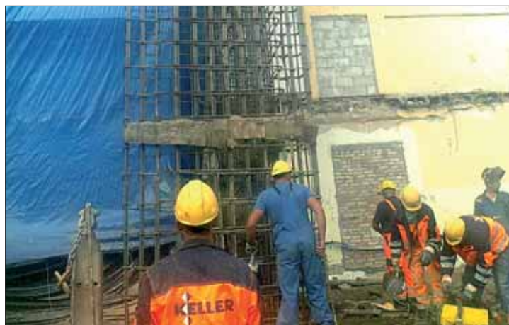
Rys. 8 Montaż zbrojenia
