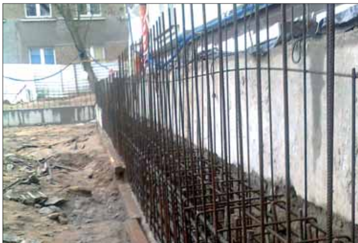
Rys. 4 Zbrojenie oczepu ścian szczelinowych
