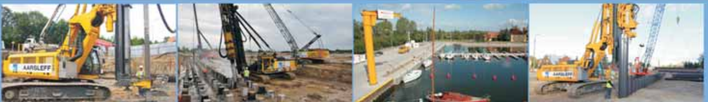
Pale przemieszczeniowe - Trzebnica
