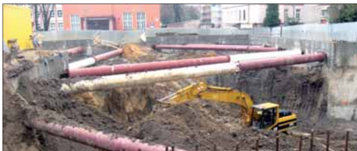
Rys. 5 Głębienie wykopu poniżej I poziomu rozparcia
