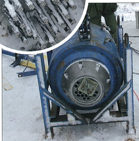
Sprężanie wykonywane było systemem francuskiej firmy Freyssinet.
