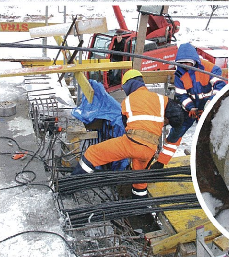
Przygotowanie wiązki kabli do sprężania.
