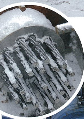
Zabetonowane po sprężeniu kable.
