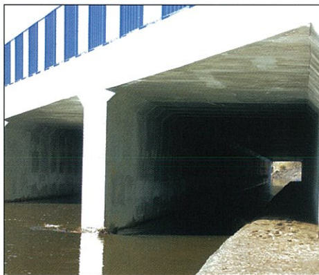
„Gwóźdź” budowy – 80-metrowy przepust pod trasą: w trakcie prac budowlanych z listopada 2012r. i stan obecny, z kwietnia 2013r.
