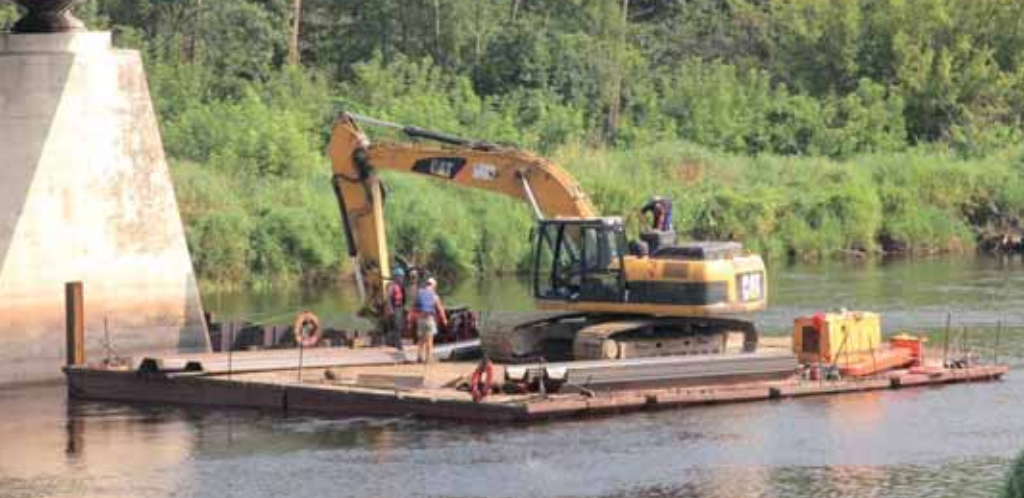
Pod koniec lipca trwało instalowanie grodzic wokół podpór mostu w nurcie rzeki. Prace prowadzone były z pontonów i... trwał wyścig z upałem. Stan wody w Narwi opadał w błyskawicznym tempie.
