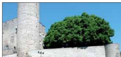
Talińska baszta – Kiek in de Kok – o średnicy ponad 17 m, grubości ścian 4 m i wysokości 44,5 m. Sześciopiętrowy obiekt ze 157 schodami wzniesiony jest w latach 1475-1481. Wykorzystywany od 1958 r.
