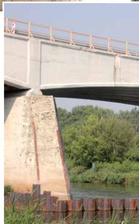
Spód konstrukcji niosącej (powierzchnie sufitowe i boczne) zostanie naprawiony poprzez zainiektowanie rys oraz uzupełnienie ubytków zaprawą PCC.
