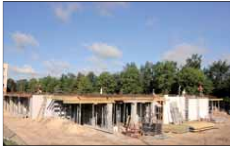
... a na początku sierpnia gotowy był już pierwszy poziom budynku.
