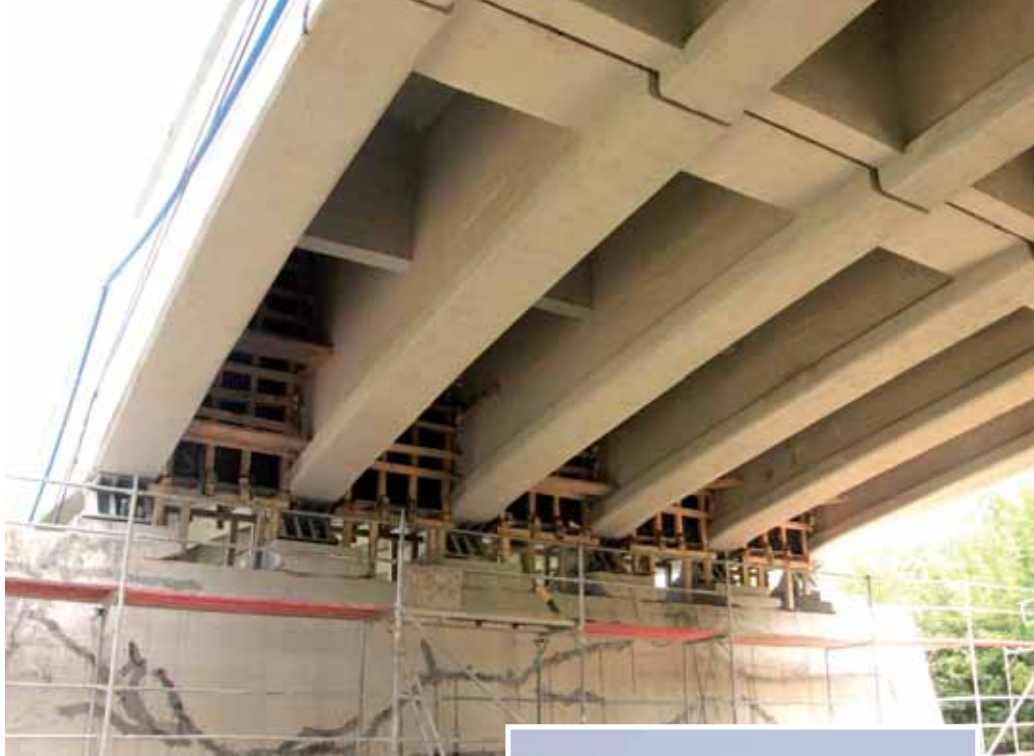
Spód konstrukcji niosącej (powierzchnie sufitowe i boczne) zostanie naprawiony poprzez zainiektowanie rys oraz uzupełnienie ubytków zaprawą PCC.
