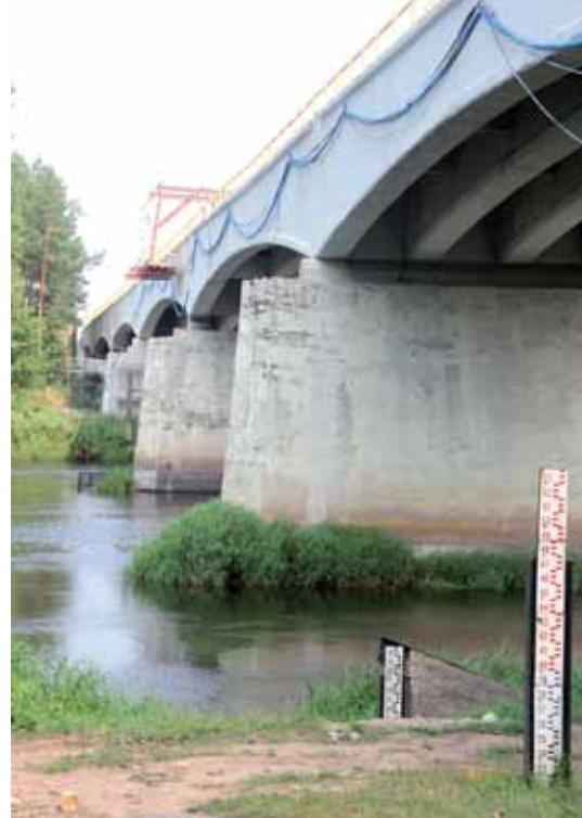
Pod koniec lipca trwało instalowanie grodzic wokół podpór mostu w nurcie rzeki. Prace prowadzone były z pontonów i... trwał wyścig z upałem. Stan wody w Narwi opadał w błyskawicznym tempie.
