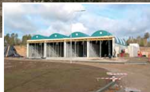
Budynek kompostowni – za nim niecka na azbest.
