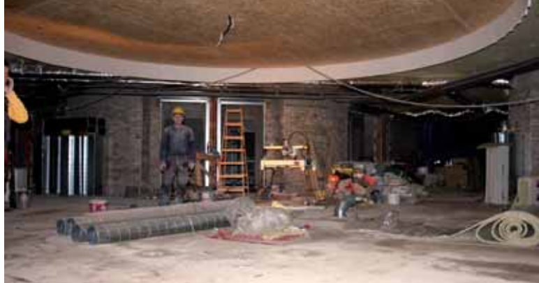
Trudnością w wykonywaniu tej inwestycji było nagromadzenie wielu ekip na tak małej powierzchni, zwyczajnie – było tu ciasno. Na zdjęciu część centralna podziemnego pasażu.
