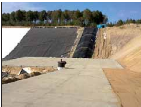
Niecka składowiska odpadów innych niż niebezpieczne – układanie izolacji.
