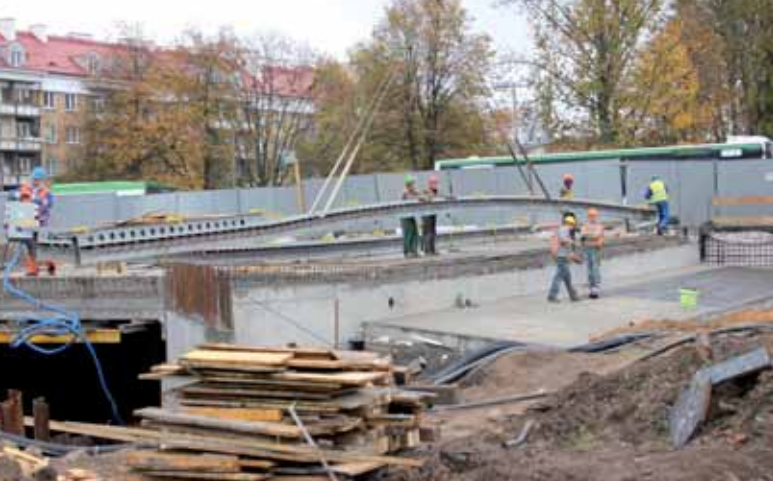
Montaż dylatacji mostu nad Białą w ciągu ul. Sienkiewicza.
