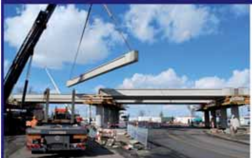
Belki IG na Obwodnicy Śródmiejskiej Wrocławia
