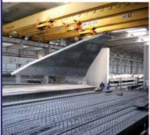
Przekrycie tunelu – Węzeł Okęcie Warszawa
