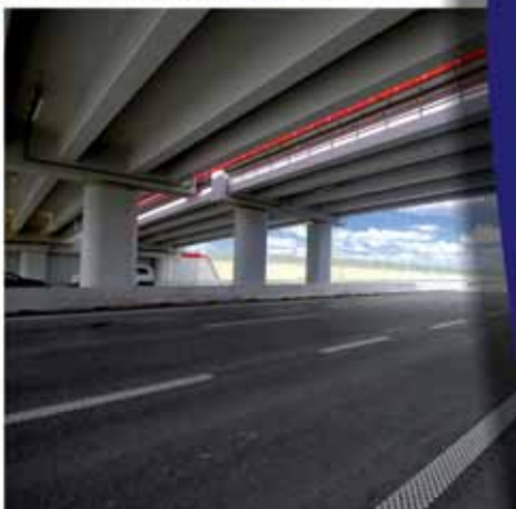
Widok mostu z belek GT – Autostrada A2 (Obiekt WD 296)
