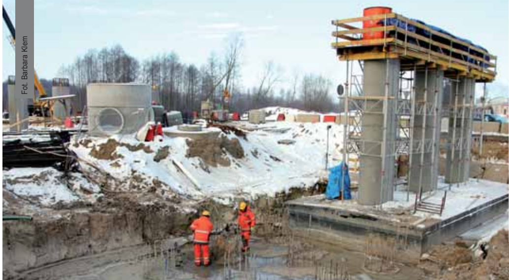
Posadowienie estakad zaplanowane zostało na palach wielkośrednicowych (1,20 m) wierconych w osłonie rury obsadowej. Na zdjęciu prace na skrzyżowaniu z ulicami: Przędzalnianą i Kołłątają.
