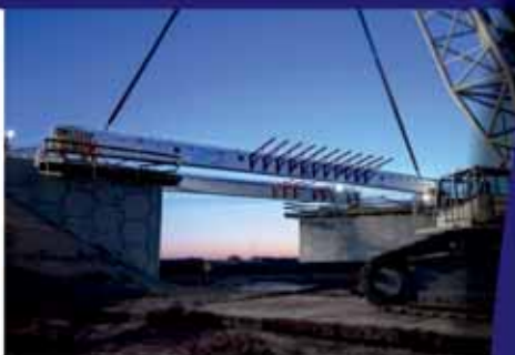
Belki struno-kablobetonowe – modernizacja linii kolejowej Warszawa-Gdynia
