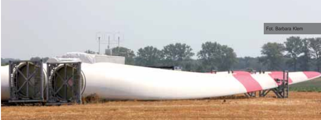
Na okładce zamieściliśmy ujęcie z najbardziej widowiskowej części montażu – w górę poszybowały zmontowane na ziemi śmigła i gondola. Tu gigantyczne łopaty czekają jeszcze na swoją kolej.
