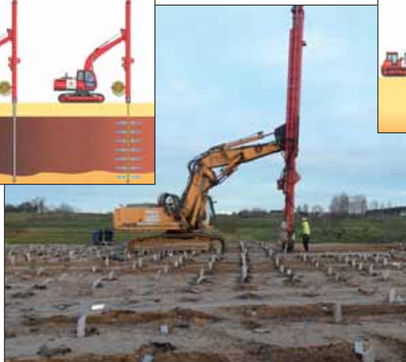
Schemat wykonania drenażu pionowego.
