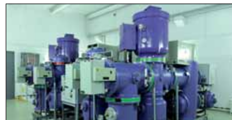
Rozdzielnia 110 kV Optima 145.
