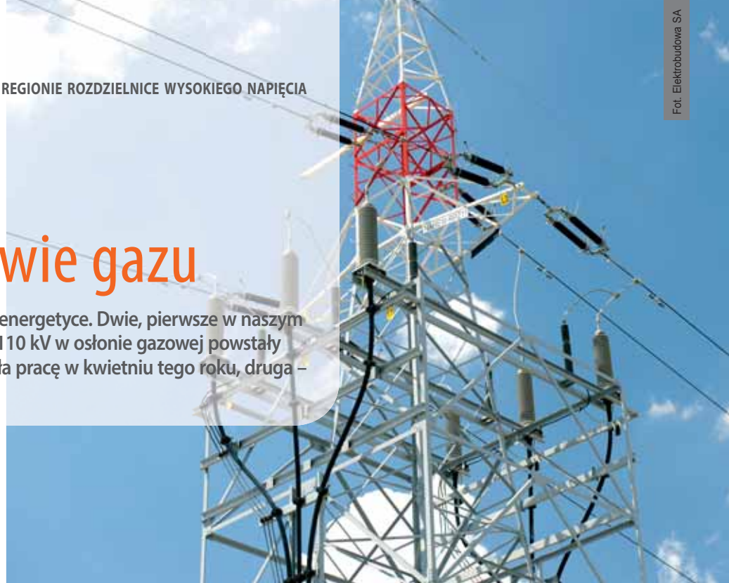
Połączenie linii kablowej 110 kV z linią napowietrzną 110 kV na słupie kratowym.
