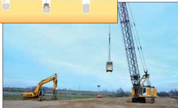
Wykonanie kolumn DR na obwodnicy Krasnopola.
