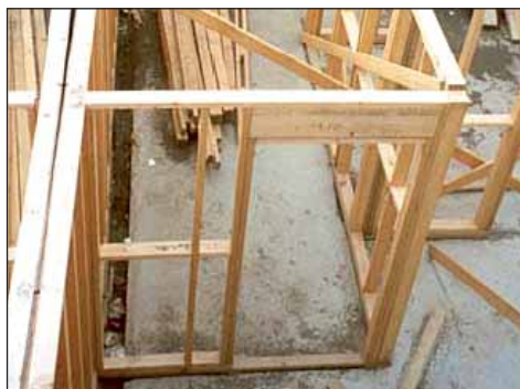
Rys.2a) Schemat jednego z tradycyjnych systemów szkieletowego budownictwa drewnianego 2b) Budynek szkieletowy w trakcie tradycyjnej realizacji.
