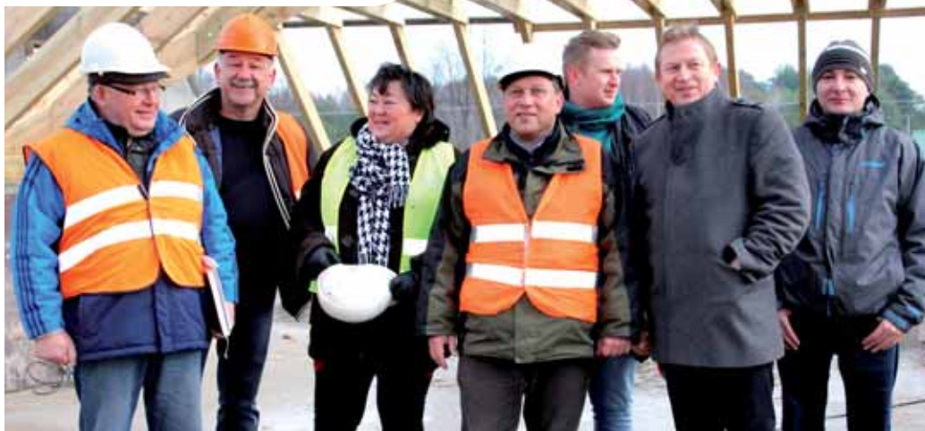
Inwestycję prowadzi parafia muzułmańska. Zarówno projektanci, jak i wykonawcy, czy nadzór muszą się wczuć w sytuację i poznać inwestora. Na zdjęciu zespół realizujący budowę: Danuta Rudnicka – kierownik budowy i (od lewej): Bronisław Talkowski – przewodniczący MGW, Roman Szymczuk – właściciel firmy wykonawczej, Robert Zimnoch – inspektor nadzoru inwestorskiego, Szymon Ołdytowski – asystent projektanta, Tomasz Ołdytowski – projektant i Jan Zerbst – asystent projektanta.
