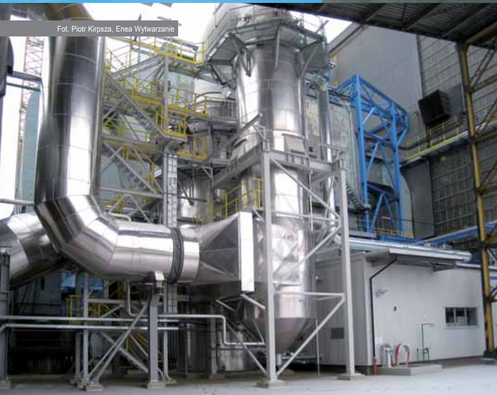
Spalanie wilgotnej biomasy w kotłach energetycznych wiąże się ze znaczną stratą kominową. Układ odzysku ciepła ze spalin zwiększa całkowitą sprawność elektrociepłowni. Zdjęcie i schemat układu.
