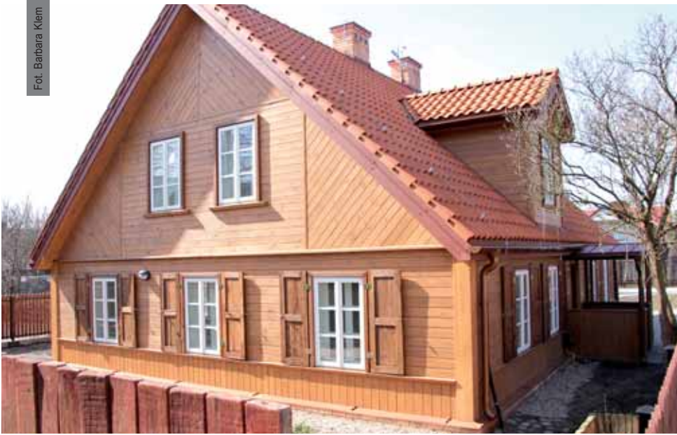
Do rodzinnego domu dziecka przy ul. Wiktorii 14 w Białymstoku lokatorzy wprowadzili się zaraz po Wielkanocy. Projekt: DF Studio Białystok; wykonawca: Gryc Budownictwo Białystok; termin realizacji: III 2014 r. – III 2015 r.
