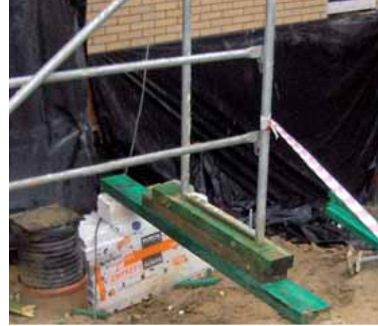
„Perfekcyjny” sposób ustawienia rusztowania.
