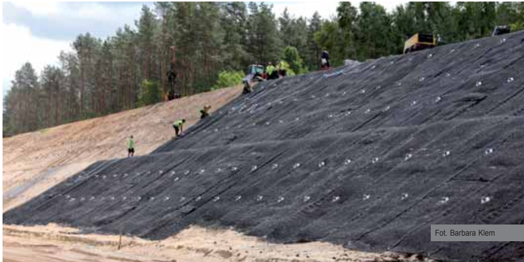
Przykładowy „gwoździez” wzmacniający. Widać wyciek nadmiaru zaczynu cementowego.
