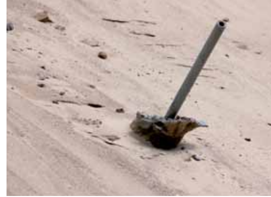
Przykładowy „gwoździez” wzmacniający. Widać wyciek nadmiaru zaczynu cementowego.
