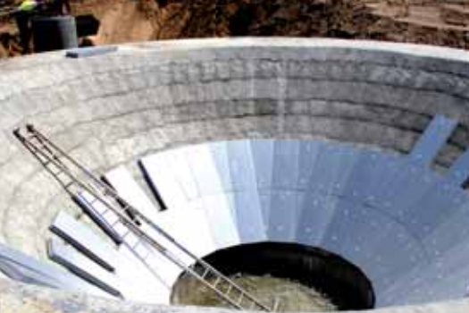
Fundament komór fermentacyjnych w trakcie realizacji.
