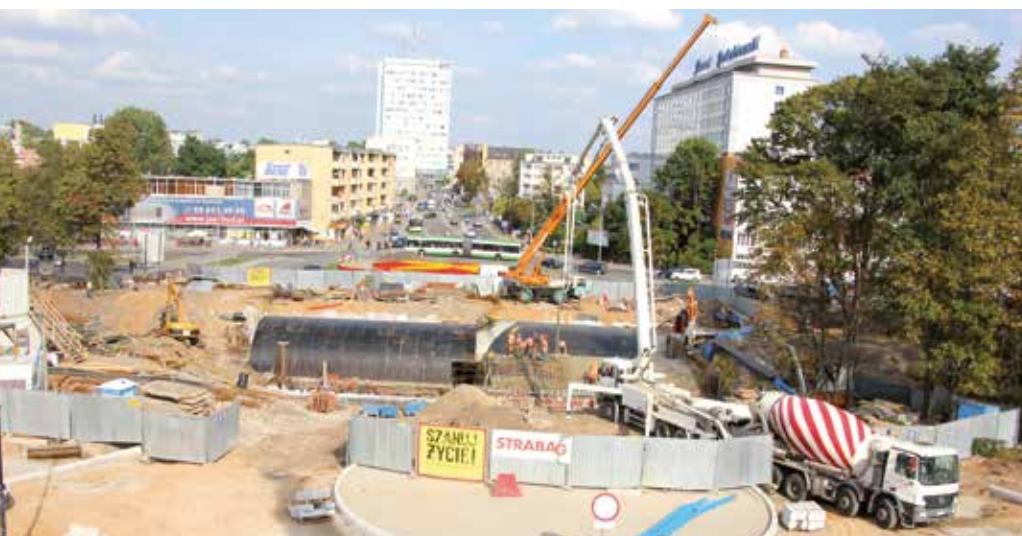
Przy okazji budowy wykonawcy zrobili generalne podziemne porządki w tej części miasta. Przebiegała tędy masa różnej infrastruktury m.in. sieci światłowodów, kabli elektrycznych, gazociągów czynnych i nieczynnych, aż po ruiny Hotelu Ritz, które przyciągnęły tu Wojewódzkiego Konserwatora Zabytków.
