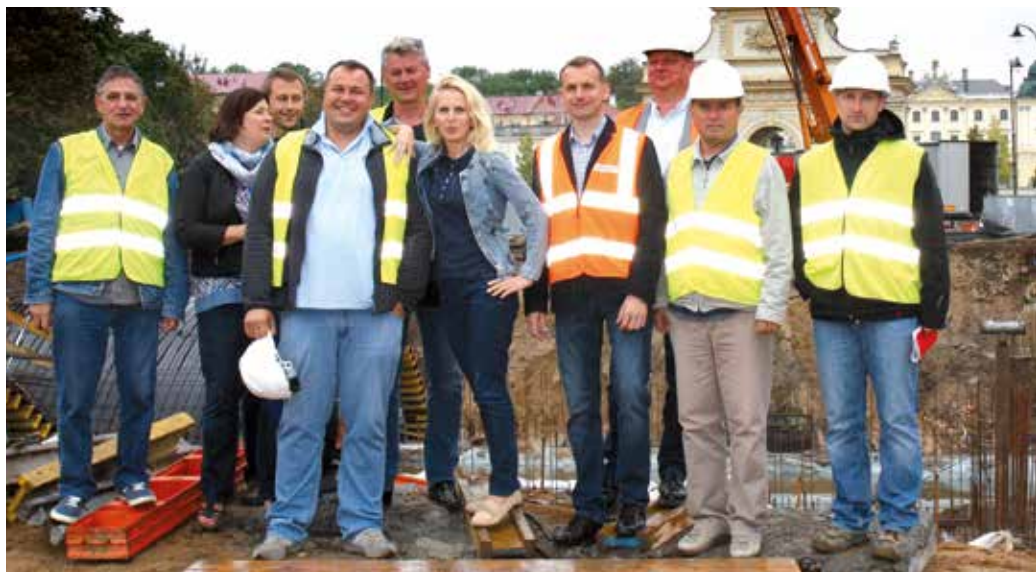
Inżynierska ekipa odpowiedzialna za realizację sfotografowana w strugach deszczu w czasie upalnego i wyjątkowo suchego lata. Aura sprzyjała pracom w okolicach rzeki, nawet niewielki deszcz powodował podniesienie poziomu wody o ponad metr i zalanie wykopu.
