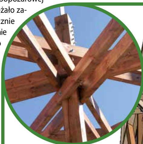
Drewniana iglica wieży wykonana jest w układzie stołcowym z tzw. świadkiem centralnym i podziałem na cztery poziomy wykonawcze.
