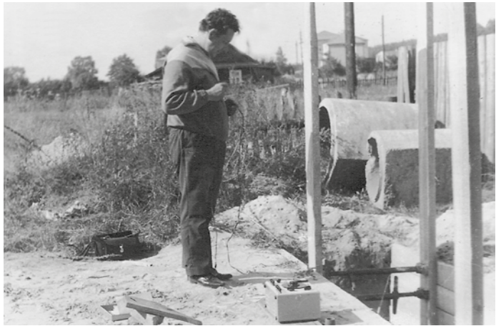
Rok 1973. Czesław Dawdo prowadzi badania obciążenia na rozpór w wykopach, przygotowuje się do pracy doktorskiej.
