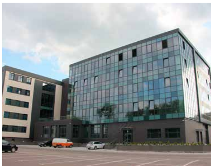
... B, to dobudowany od podstaw nowy budynek w głębi działki
