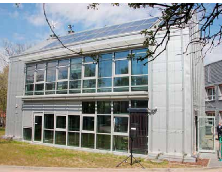
Szara blacha z czasem zmienia się dzięki pnączom fasadowym, które zintegrują go z zielonym otoczeniem, wprowadzają jesienną zmienność kolorów oraz ocieniają ściany w czasie upałów. Na zdjęciu elewacja południowa...
