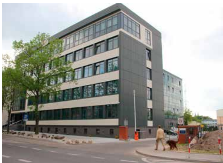
Obiekt wizualnie dzieli się na segmenty A i B. Przebudowany i wyremontowany fragment trzypiętrowej szkoły od ul. Świętojańskiej to segment A...
