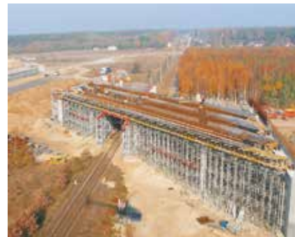
Wiadukt nad czynną linią kolejową, Autostrada A1
