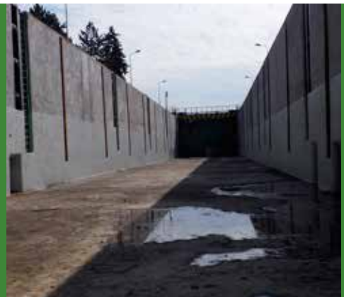
Wyremontowana – jeszcze sucha – śluza
