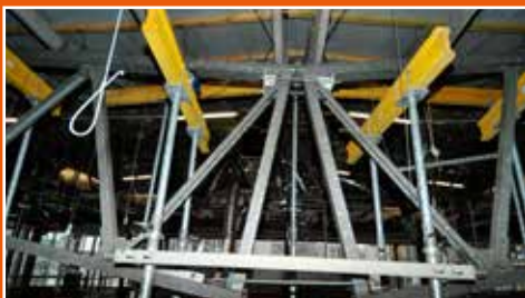
Etapy realizacji rekonstrukcji (podnoszenia i scalania) segmentów dźwigara
