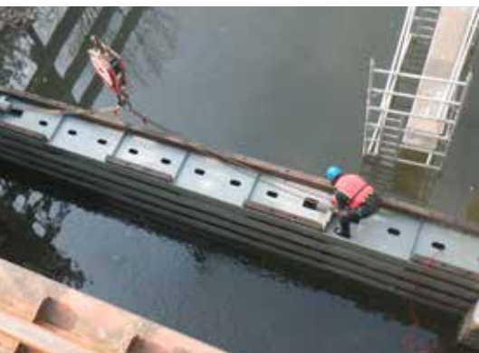
Układanie szandorów zamykających śluzę na czas remontu
