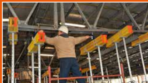
Etapy realizacji rekonstrukcji (podnoszenia i scalania) segmentów dźwigara
