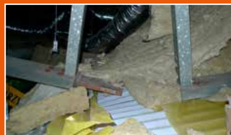
Uszkodzone połączenie segmentów dźwigara
