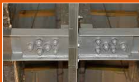
Uszkodzone połączenie segmentów dźwigara
