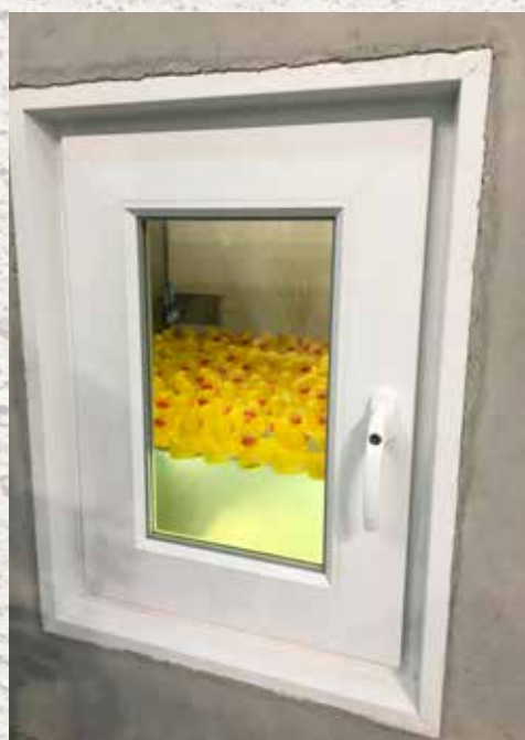
Betonowe ściany piwniczne w technologii „białej wanny” – nie wymagają izolacji przeciwwilgociowych ani przeciwwodnych
