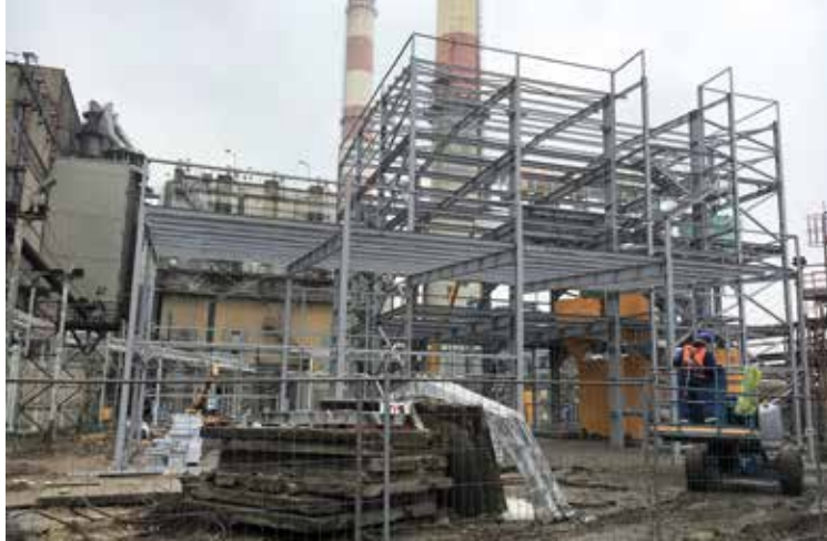
Początek montażu – styczeń 2016 r.
