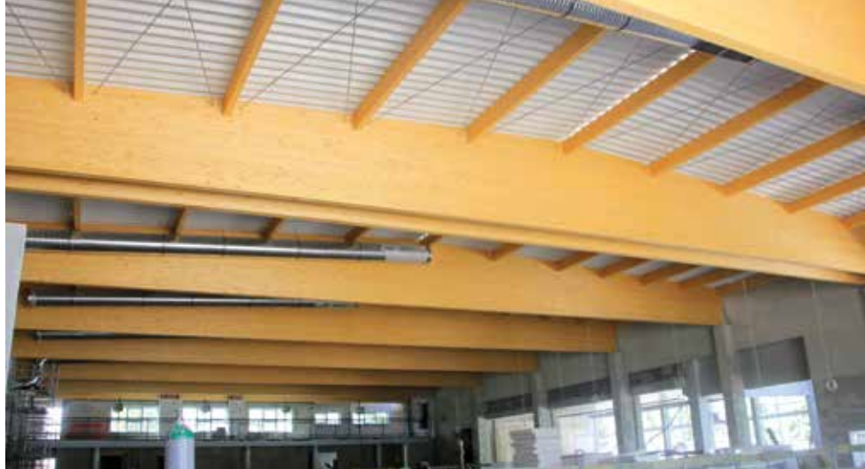
Stare konstrukcje stalowe dachu zastąpiło drewno klejone.
