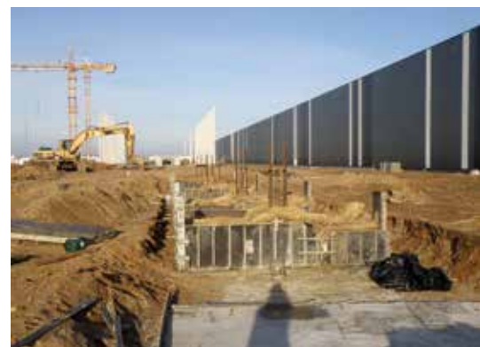
Po prawej stronie widać część pierwszej, gotowej już hali magazynowej, z lewej – budowa kolejnej
