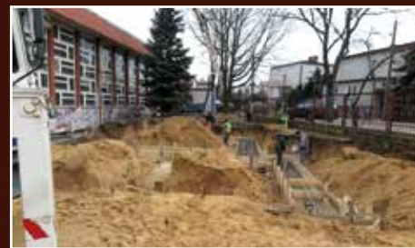
Budowa ruszyła 1 marca 2016 r.
