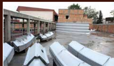
Elementy konstrukcyjne dachu
