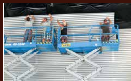
Wykonywanie poszycia wewnętrznego
