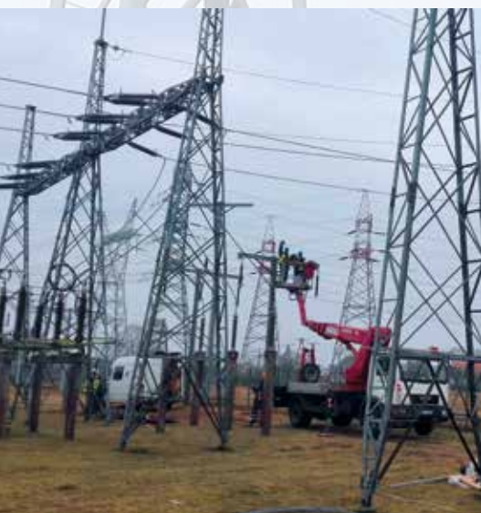
Jedno z pól stacji przed modernizacją...
