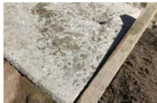
Powierzchnię schodów, piaskowce i nowy torkret, czyli beton natryskowy, został pokryty specjalnym impregnatem, który powoduje taki efekt – woda nie zwilża powierzchni
