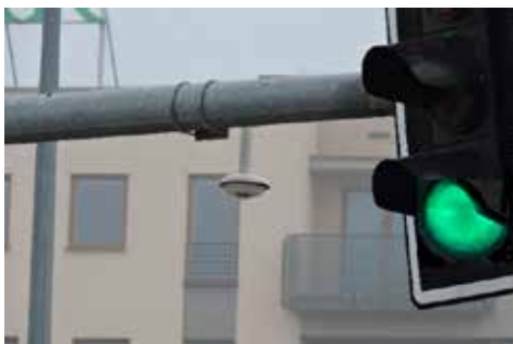
Białystok jako pierwsze miasto w Polsce zrealizowało monitoring wszystkich skrzyżowań za pomocą kamer z matrycą SMPx i obiektywem typu fisheye
