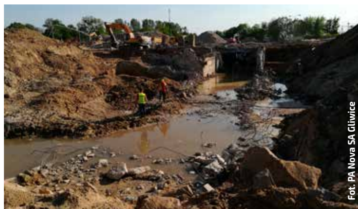
Rozbiórka przejścia stała się pretekstem do prima-apriliśowego żartu przygotowanego przez dziennikarzy, jakoby znaleziono tu schron. Zdjęcie pokazuje jednocześnie jak trudne warunki gruntowe są na budowie
