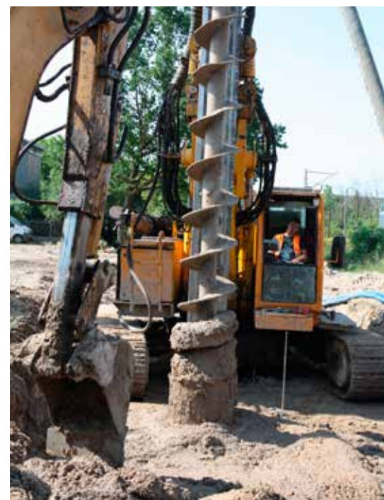
Wykonywanie prac palowych. Etap betonowania. Pale mają średnicę 600 mm i długość 12 m
