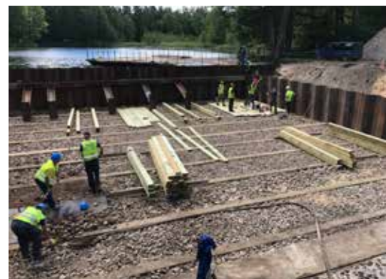
Odwodnione stanowisko awanportu górnego. Drewniane legary oparte na palach stalowych oraz pokład drewniany z wypełnieniem narzutem kamiennym stanowią podłogę drewnianą umacniającą dno wejścia do śluzy
