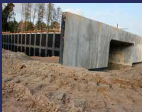
Prefabrykowany przepust skrzynkowy pod drogą główną o przekroju 2,0x4,5m i długości 39,0m. Ciekawy będzie też jednoprzęsłowy most nad Czaplbianką posadowiony na palach wierconych
