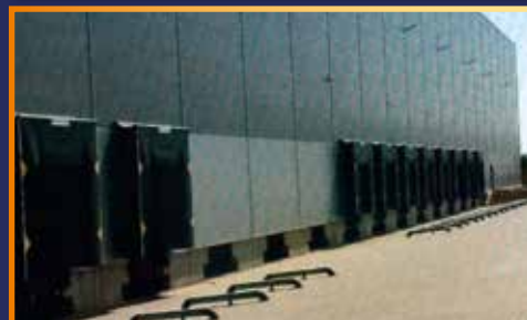
Hala magazynowa z częścią biurowo-socjalną w Koluszkach
