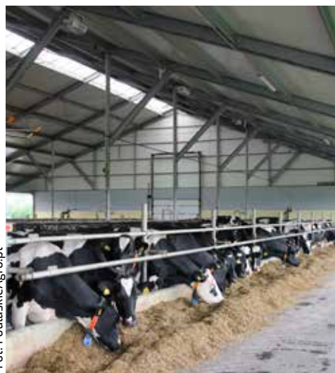
Korytarz paszowy. Miejsce, gdzie wysypuje się pasze tzw. stół paszowy wzmocnia się żywicą
