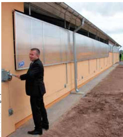
Ściany boczne obór są wyposażane w tzw. kurtyny powietrzne
