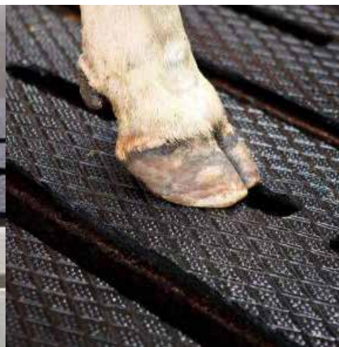
Betonowe ruszta przykrywa się gumowymi matami, aby bydło mogło się bezpieczniej poruszać
