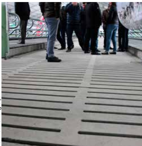
Podłoga rusztowa, to najnowsze rozwiązanie pozbywania się gnojowicy z obory
