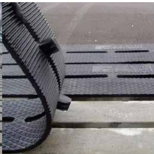
Betonowe ruszta przykrywa się gumowymi matami, aby bydło mogło się bezpieczniej poruszać
