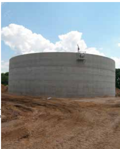
Przykładowy zbiornik na gnojowicę wysoki na 8 m o pojemności 3 mln litrów
