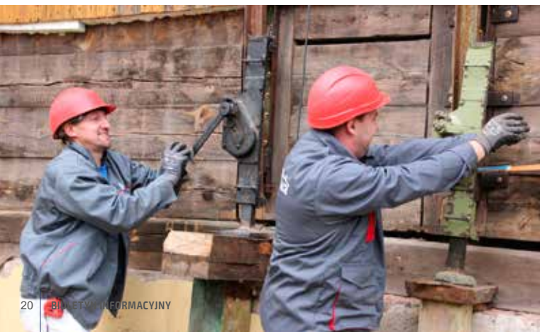
Kulminacyjny moment pracy – podnoszenie budynku. Szkoda, że to tylko zdjęcie a nie film
